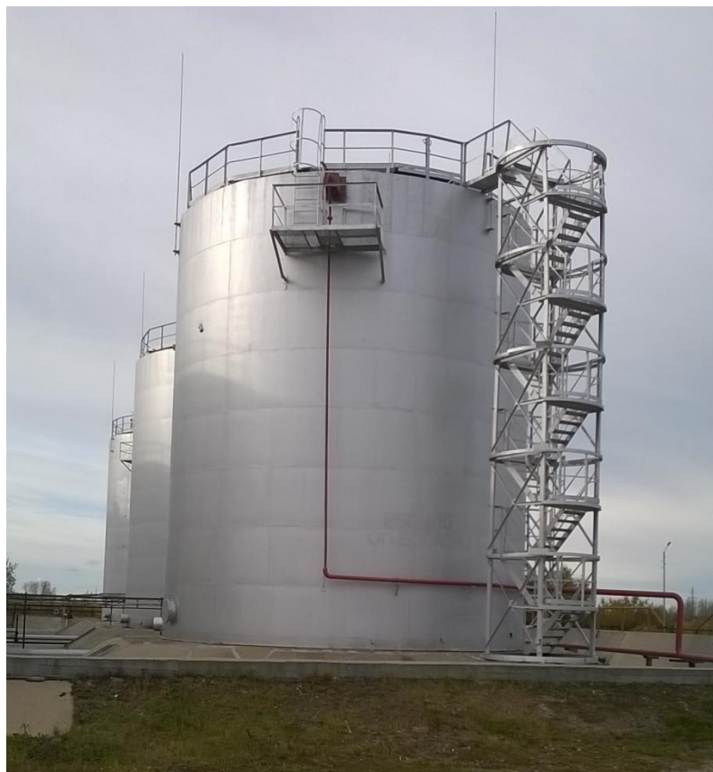
Рисунок 1 - Общий вид резервуара РВС-1000
