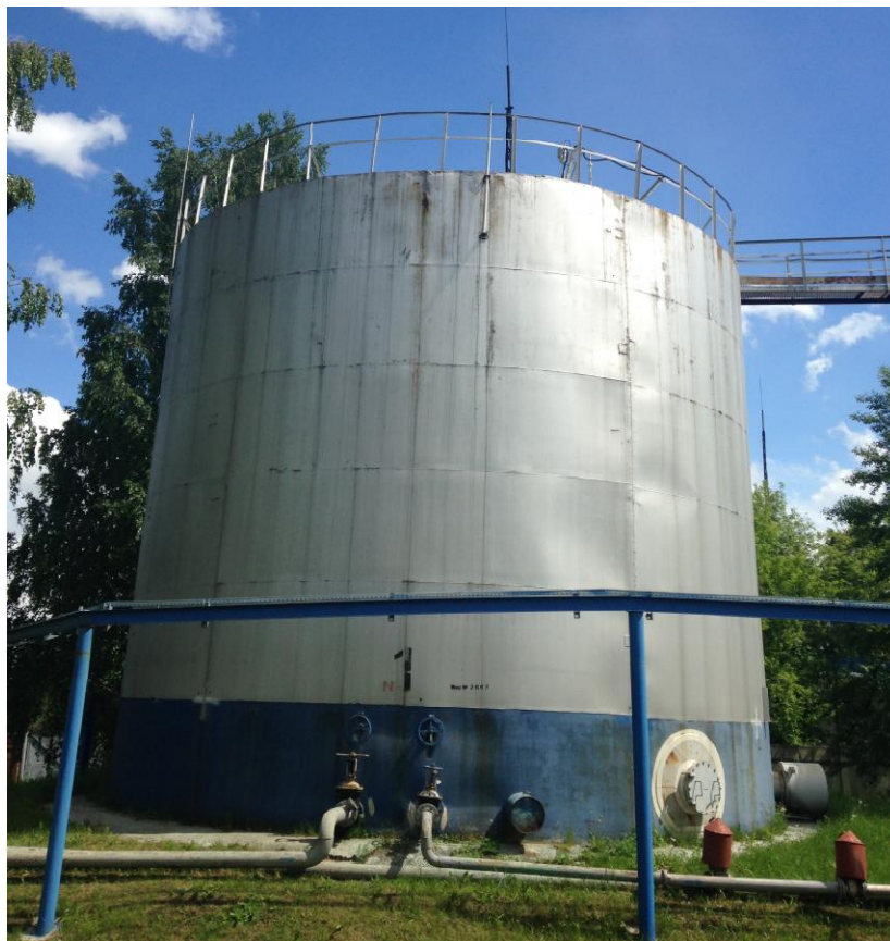
Рисунок 2 - Общий вид резервуара вертикального стального цилиндрического РВС-700
