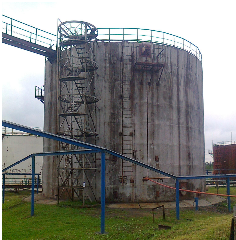
Рисунок 1 – Общий вид резервуара вертикального стального цилиндрического РВС-2000
