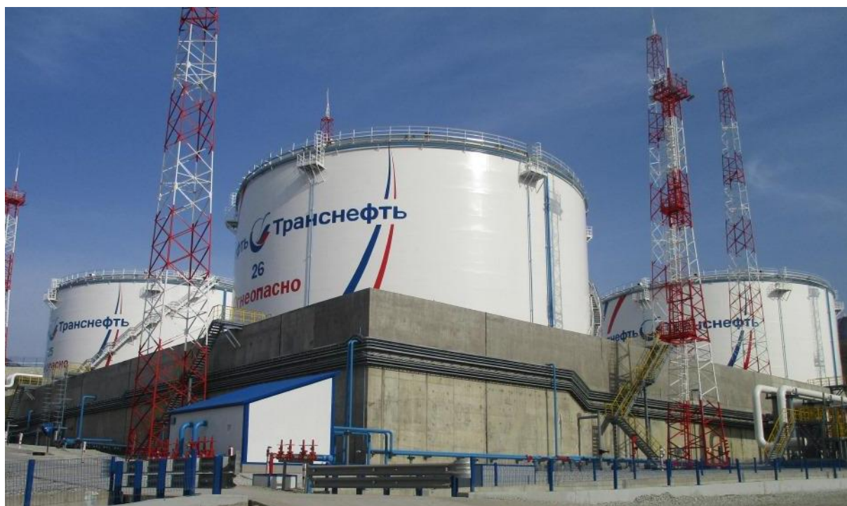
Рисунок 1 – Общий вид резервуара РВСП-30000
