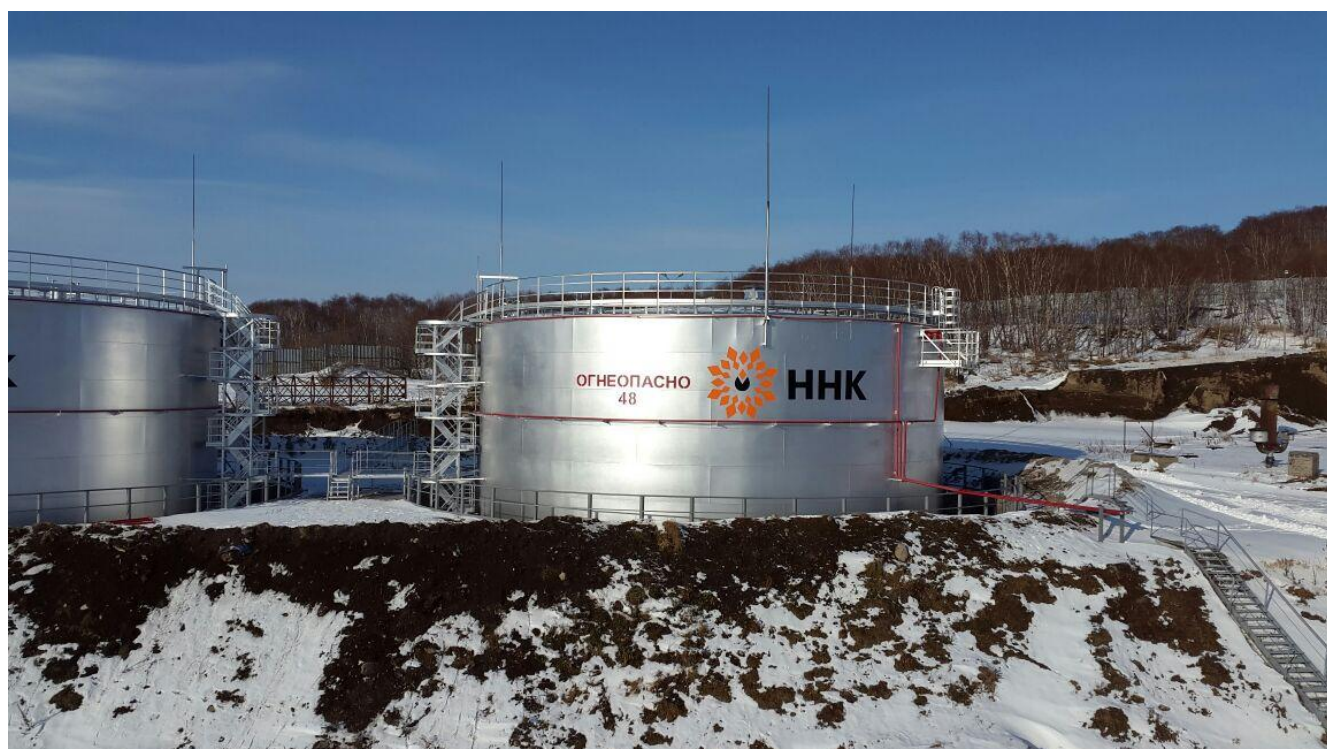
Рисунок 1 - Общий вид резервуара РВС-5000
