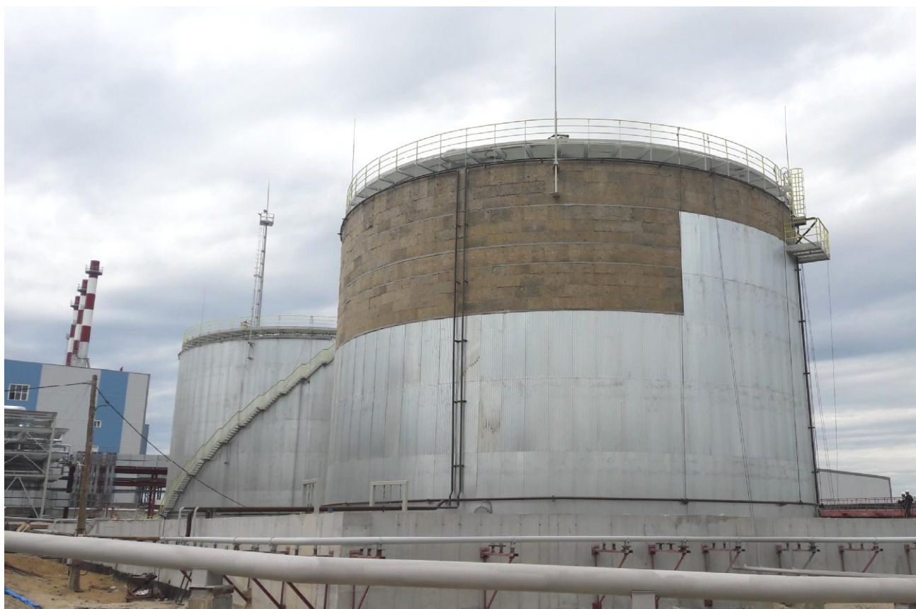
Рисунок 1 - Общий вид резервуаров
