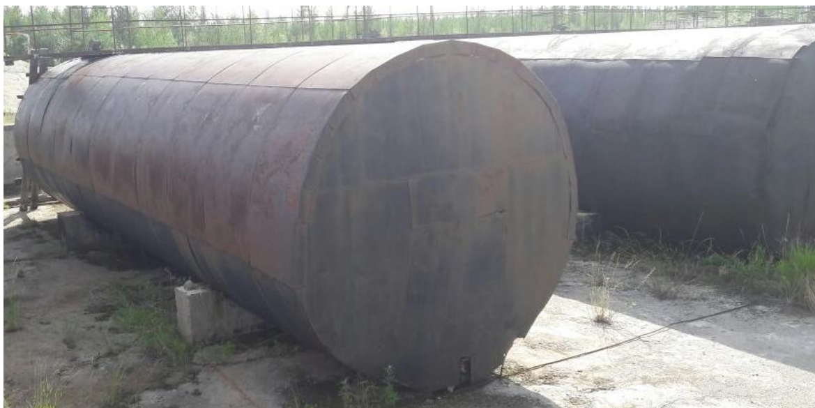
Рисунок 2 - Общий вид резервуара РГС-60
