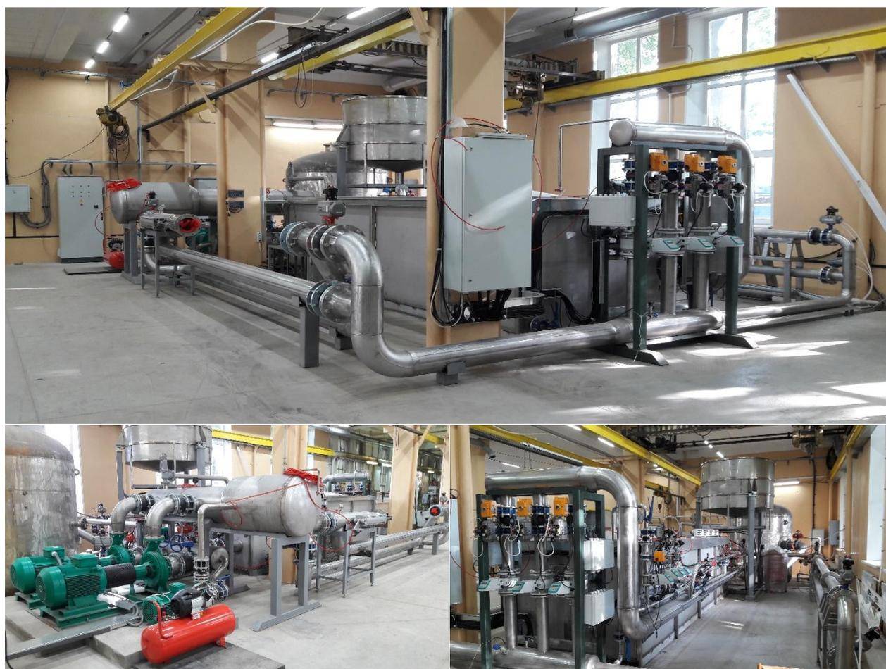
Рисунок 1 - Общий вид установок поверочных горячеводных автоматизированных УПГА
