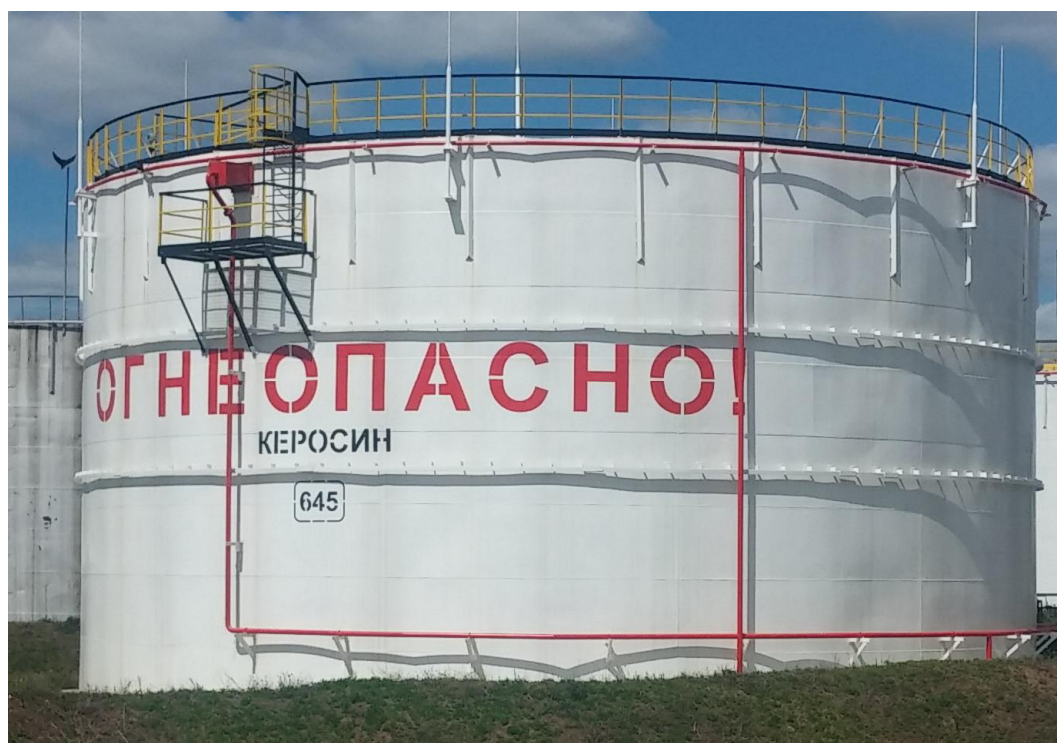
Рисунок 3 - Общий вид резервуаров вертикальных стальных цилиндрических РВС-5000
