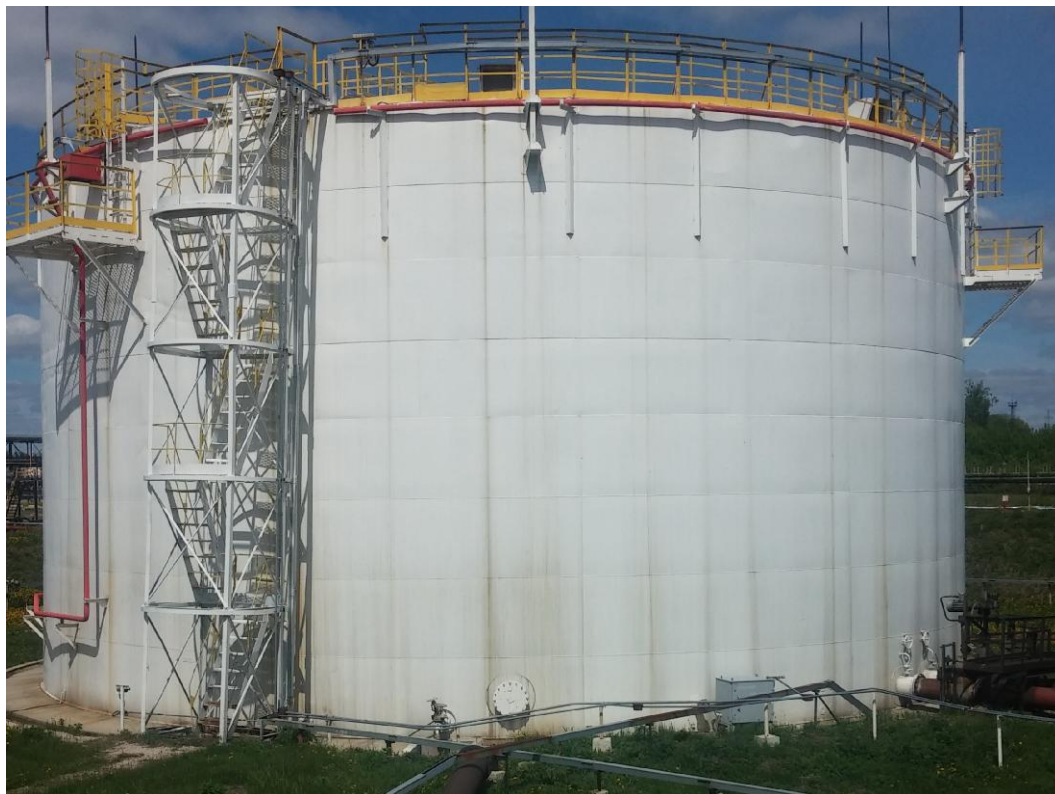
Рисунок 2 - Общий вид резервуаров вертикальных стальных цилиндрических РВСП-5000
