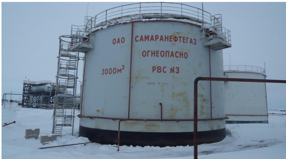
Рисунок 3 - Общий вид резервуара стального вертикального цилиндрического РВС-3000
