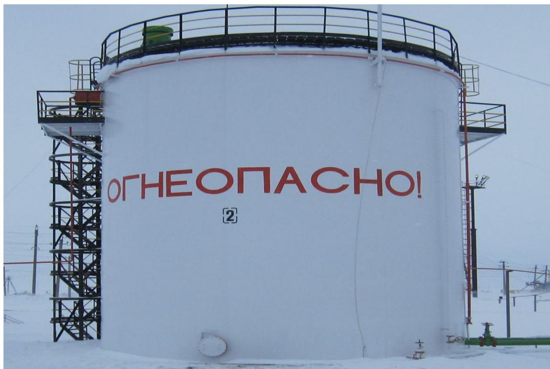
Рисунок 1 - Общий вид резервуара стального вертикального цилиндрического РВС-1000
