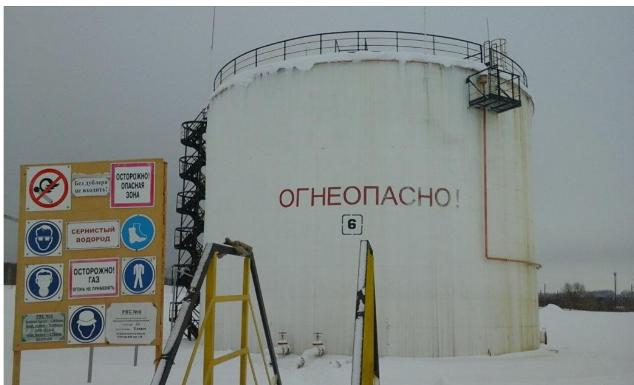
Рисунок 2 - Общий вид резервуара стального вертикального цилиндрического РВС-5000
