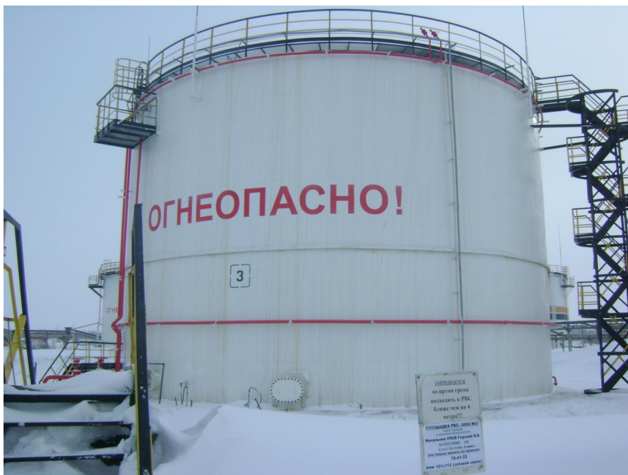
Рисунок 1 - Общий вид резервуара стального вертикального цилиндрического РВС-3000
