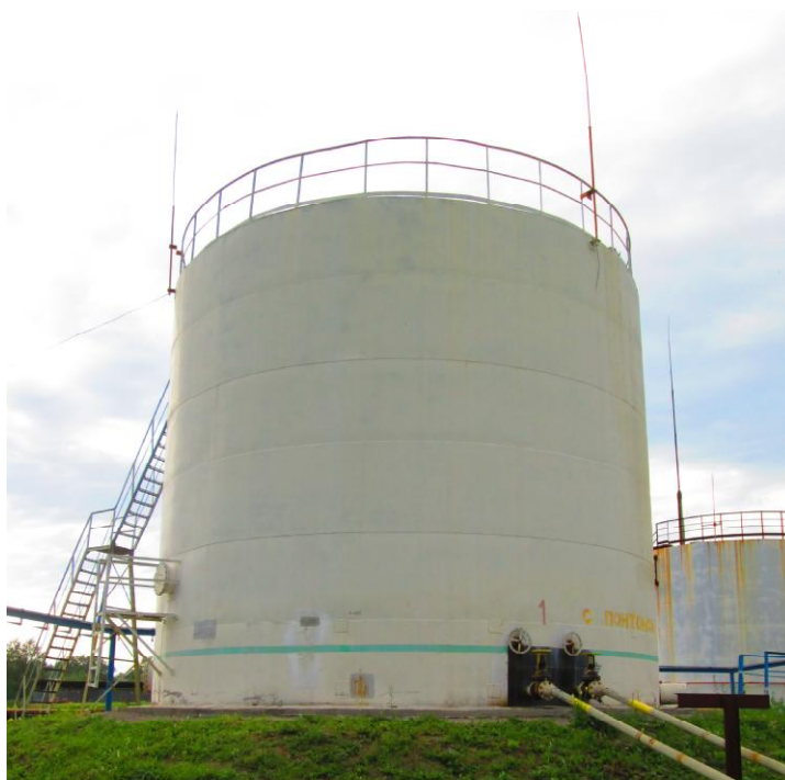
Рисунок 2 – Общий вид резервуара вертикального стального цилиндрического РВСП-700
