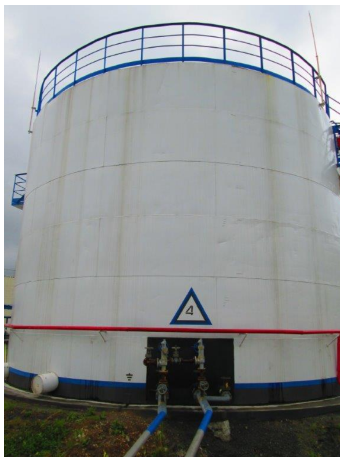
Рисунок 3 – Общий вид резервуара вертикального стального цилиндрического РВС-1000
