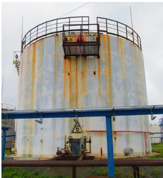
Рисунок 4 – Общий вид резервуара вертикального стального цилиндрического РВСП-1000
