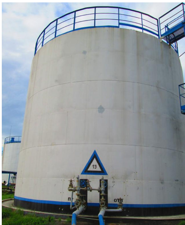
Рисунок 1 – Общий вид резервуара вертикального стального цилиндрического РВС-700
