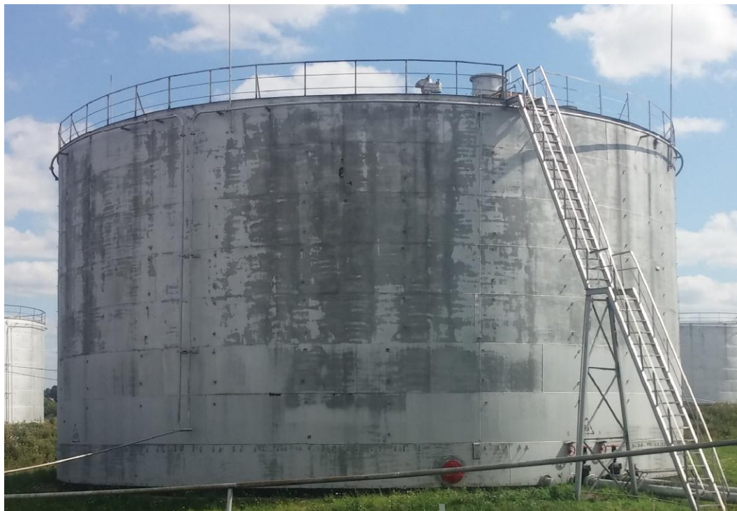
Рисунок 1 - Общий вид резервуаров вертикальных стальных цилиндрических РВС-5000
