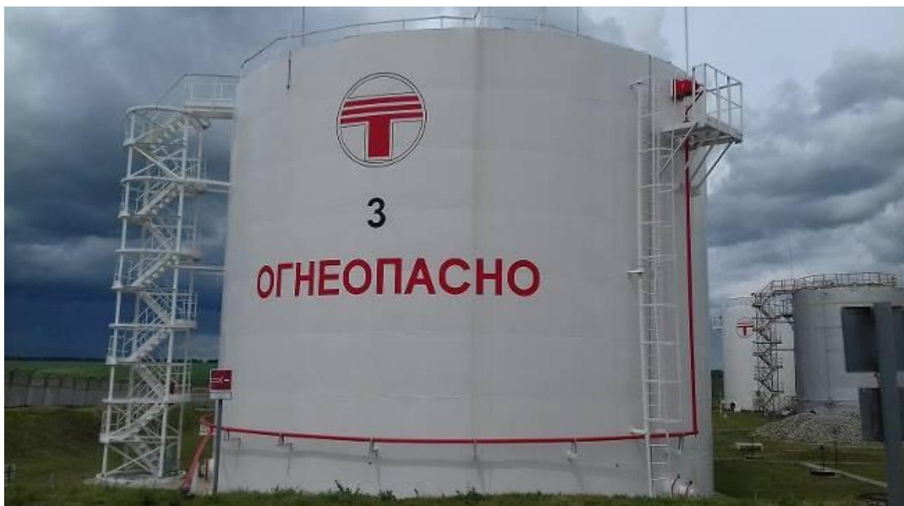
Рисунок 1 – Общий вид резервуара вертикального стального цилиндрического РВС-2000
