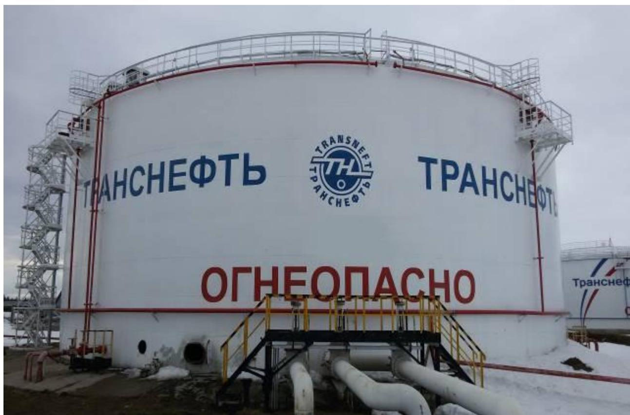
Рисунок 2 – Общий вид резервуара вертикального стального цилиндрического РВСП-1000
