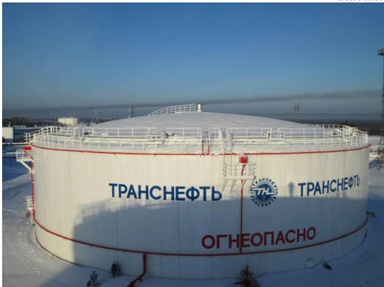
Рисунок 3 – Общий вид резервуара вертикального стального цилиндрического РВСП-20000
