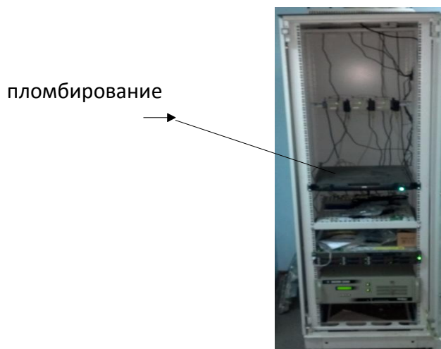
Рисунок 2 - Место пломбирования сервера АСКУ ТЭР
