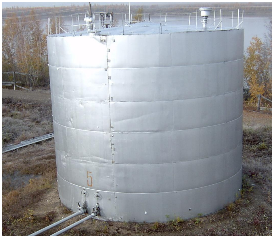
Рисунок 3 - Общий вид резервуара РВС-700
