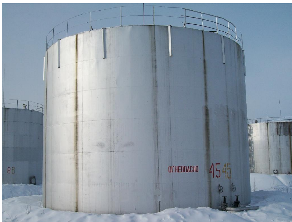
Рисунок 4 - Общий вид резервуара РВС-1000
