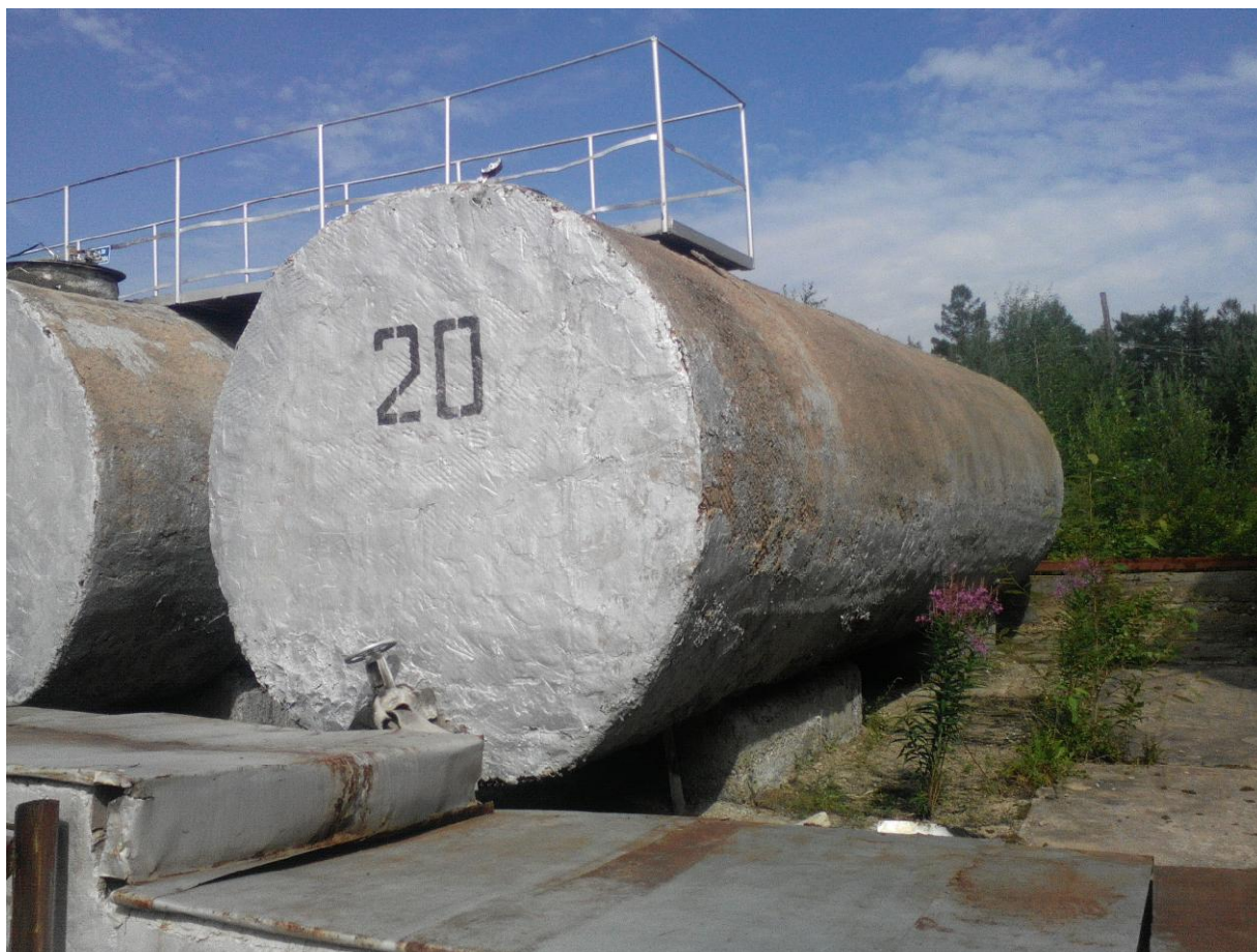
Рисунок 1 - Общий вид резервуара РГС-50
