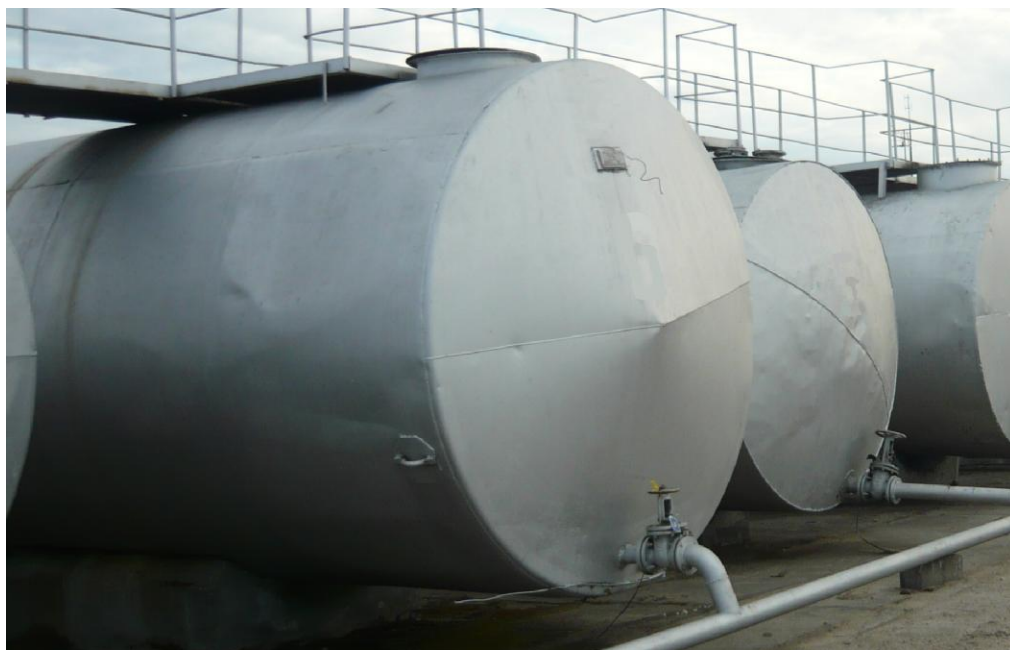
Рисунок 2 - Общий вид резервуара РГС-60
