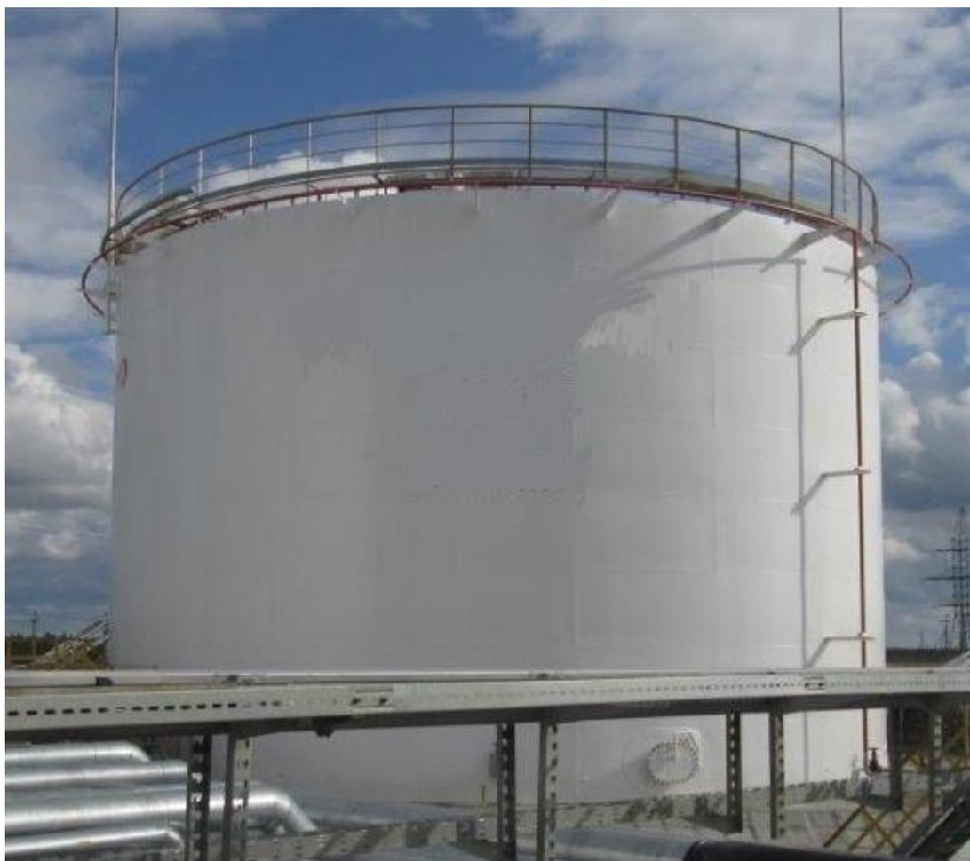
Рисунок 1 - Общий вид резервуара стального вертикального цилиндрического РВС-3000
