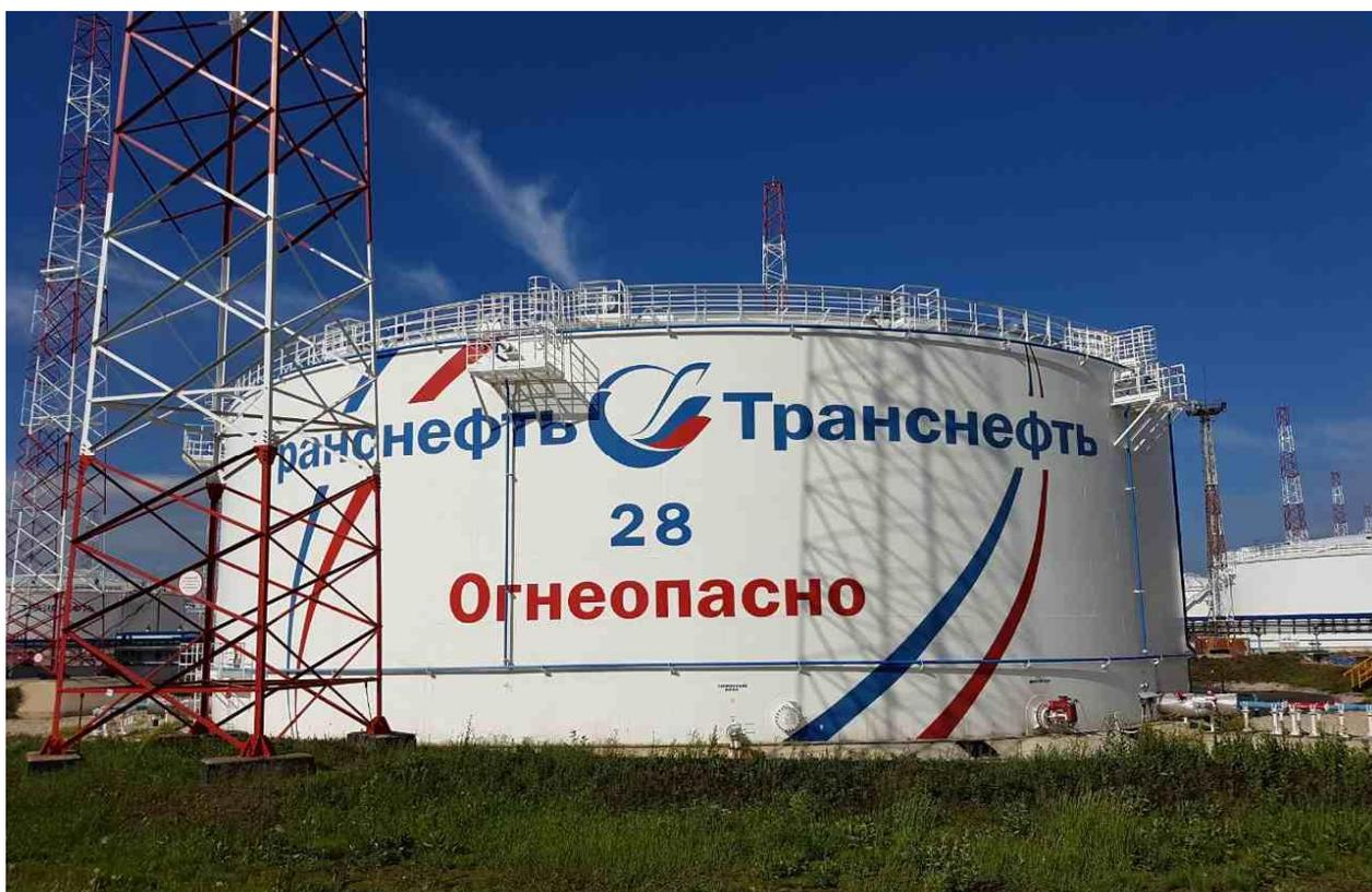
Рисунок 2 - Общий вид резервуара вертикального стального цилиндрического РВСП-20000
