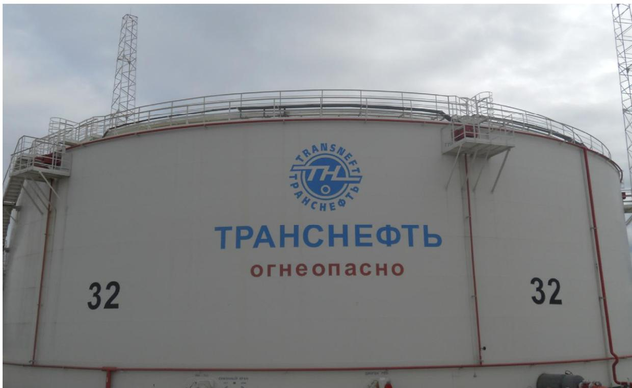
Рисунок 1 - Общий вид резервуара вертикального стального цилиндрического РВС-20000
