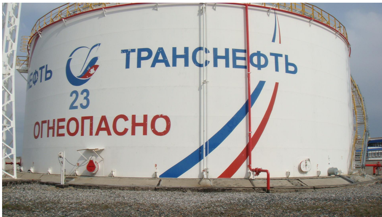
Рисунок 1 - Общий вид резервуара вертикального стального цилиндрического РВС-10000
