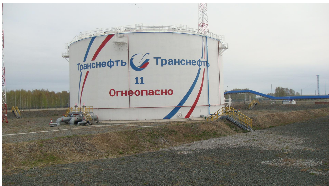
Рисунок 2 - Общий вид резервуара вертикального стального цилиндрического РВСП-20000
