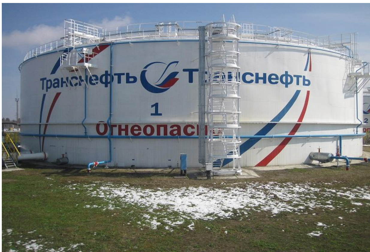
Рисунок 1 - Общий вид резервуара вертикального стального цилиндрического РВС-20000
