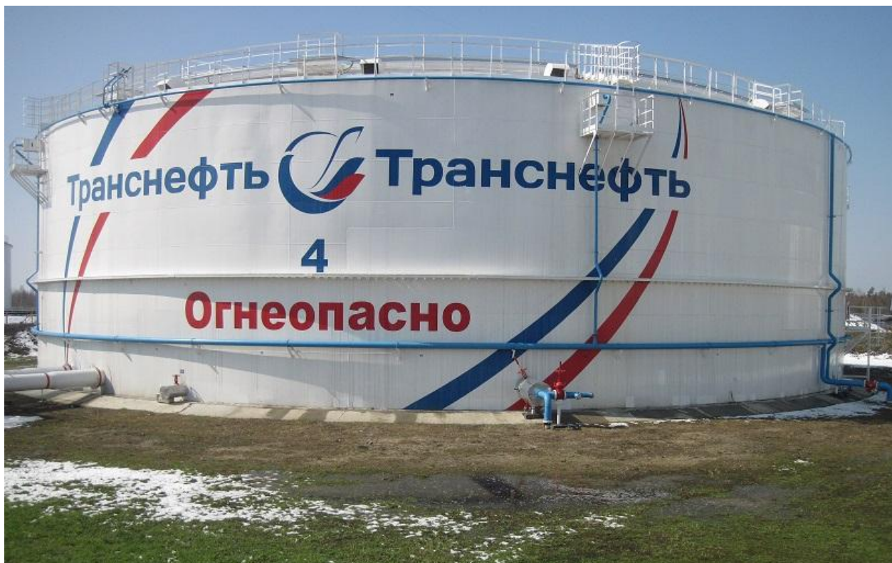
Рисунок 2 - Общий вид резервуара вертикального стального цилиндрического РВСП-20000
