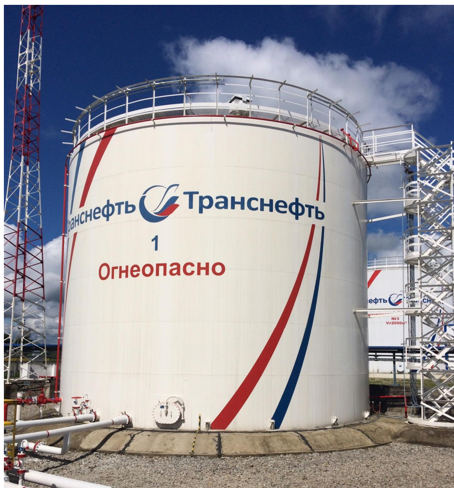
Рисунок 1 - Общий вид резервуара вертикального стального цилиндрического РВС-2000
