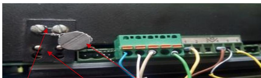
Пломбировочная проволока      Планка блока переключателей      Пломба поверителя (1 шт)
