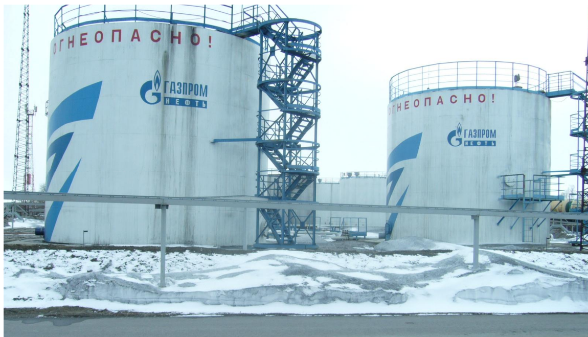
Рисунок 1 – Общий вид резервуаров вертикальных стальных цилиндрических РВС-700
