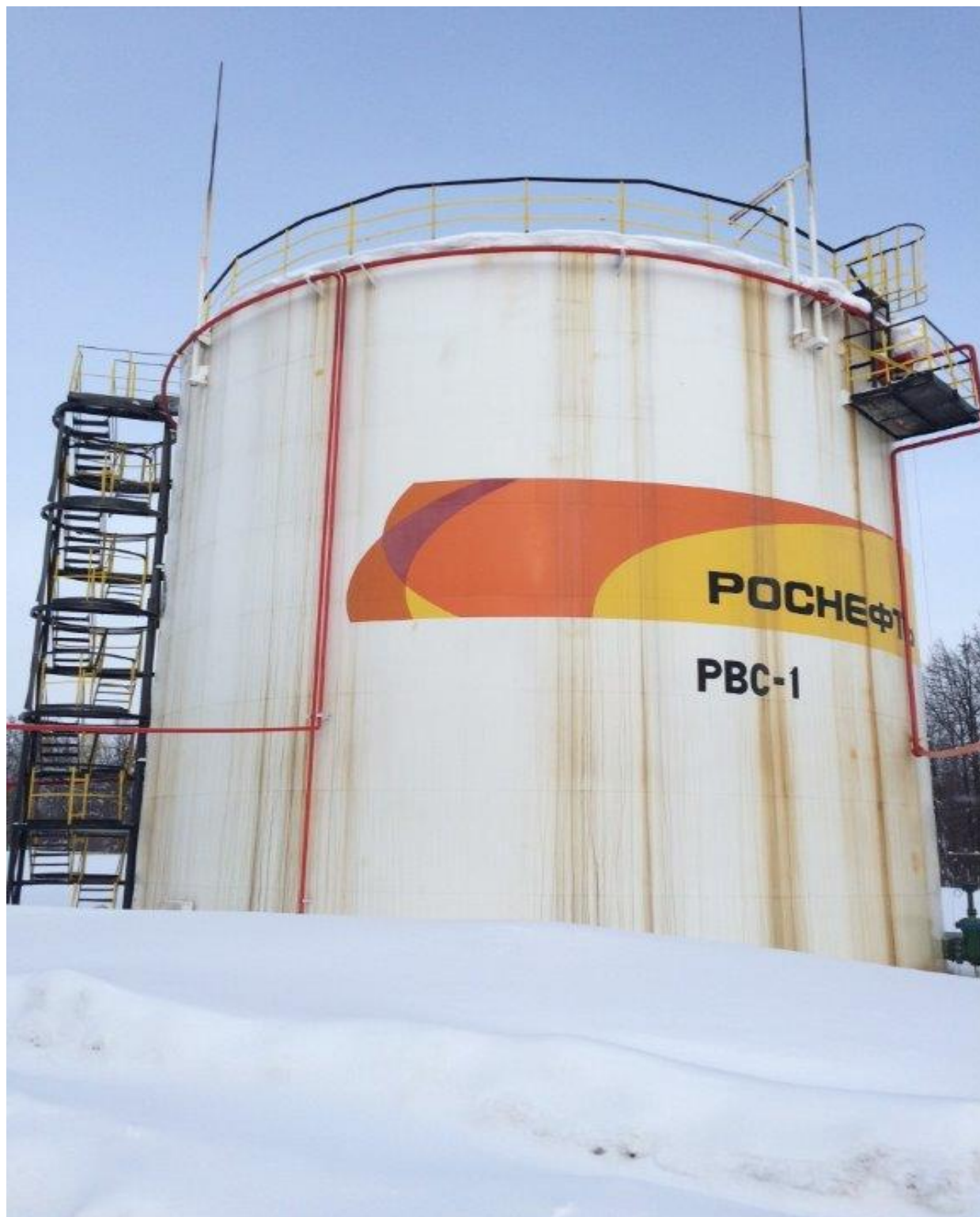
Рисунок 2 - Общий вид резервуара стального вертикального цилиндрического РВС-2000
