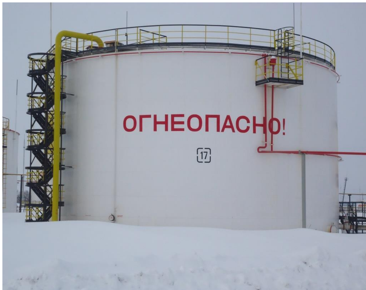
Рисунок 5 - Общий вид резервуара стального вертикального цилиндрического РВС-5000
