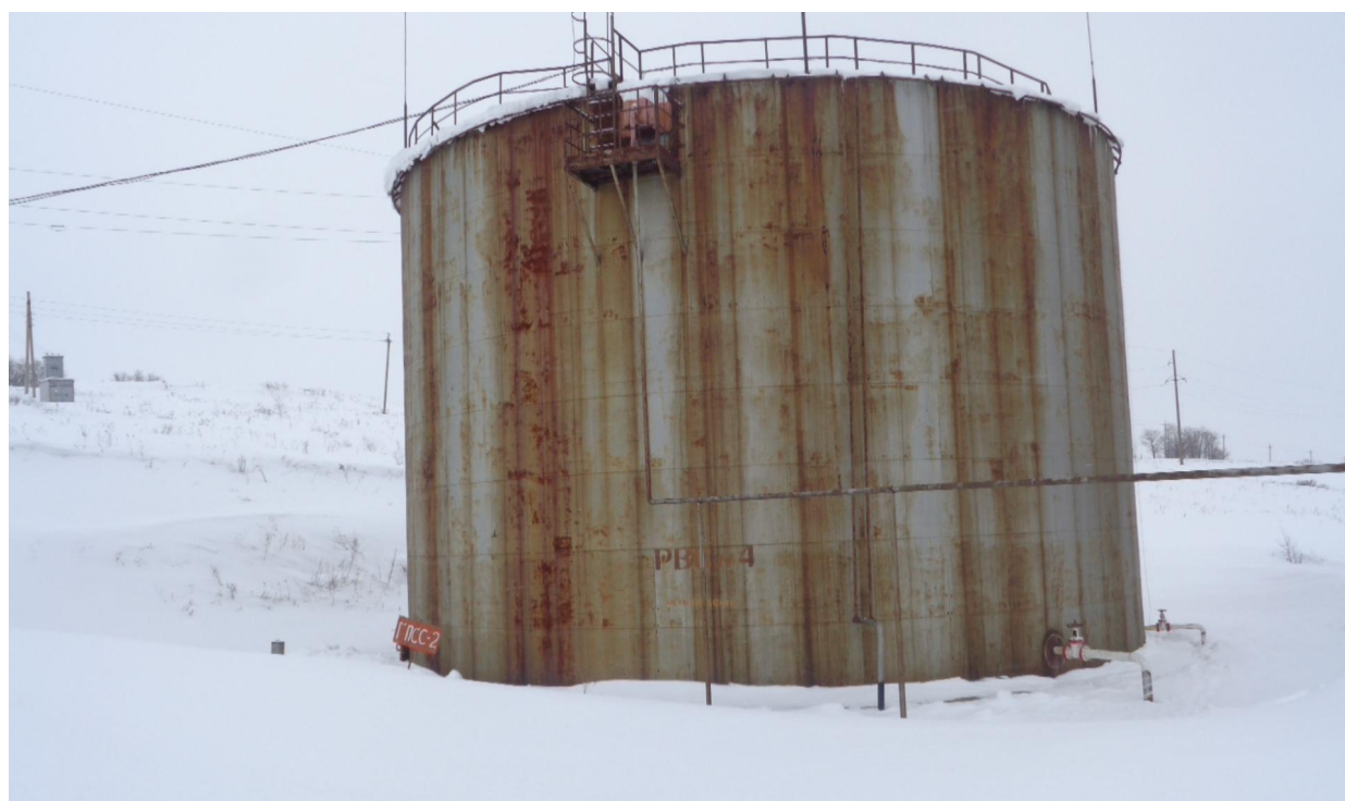
Рисунок 3 - Общий вид резервуара стального вертикального цилиндрического РВС-3000
