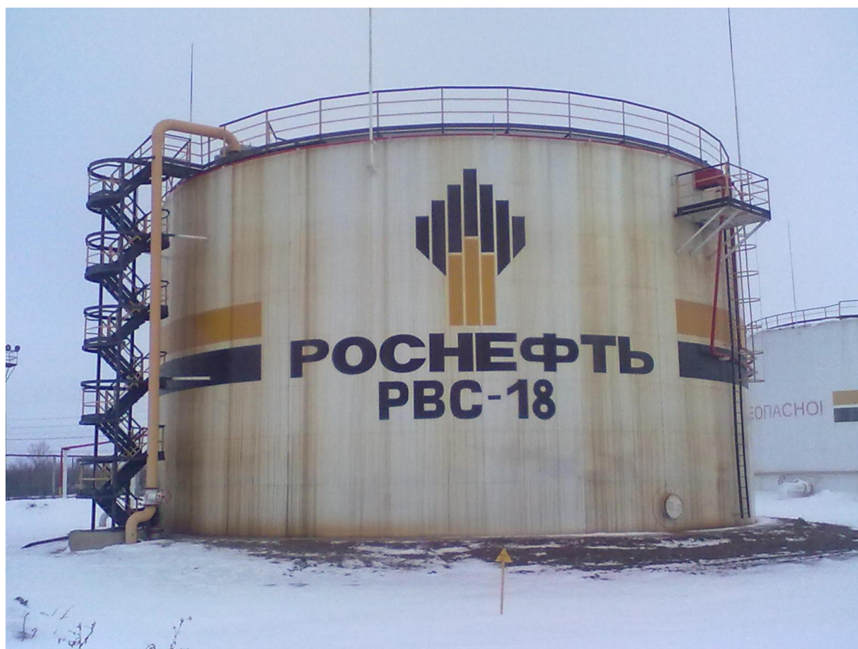
Рисунок 4 - Общий вид резервуара стального вертикального цилиндрического РВС-4000
