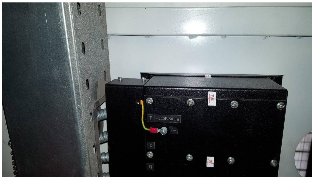
Рисунок 6 - Место пломбирования в целях предотвращения несанкционированной настройки и вмешательства
