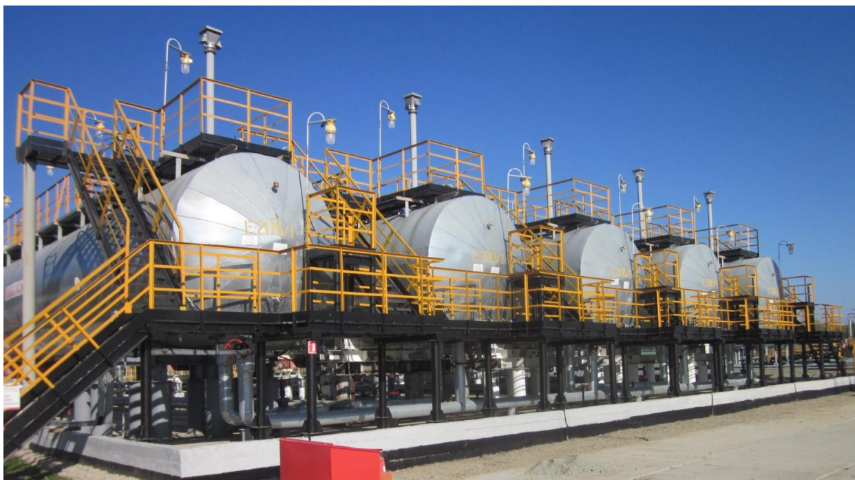
Рисунок 2 – Общий вид резервуаров горизонтальных стальных цилиндрических РГС-200
