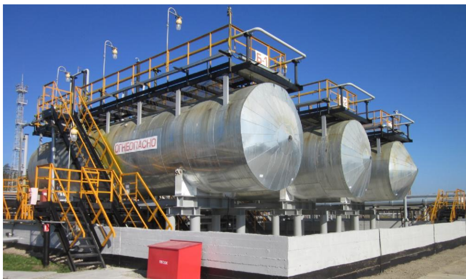
Рисунок 1 – Общий вид резервуаров горизонтальных стальных цилиндрических РГС-100
