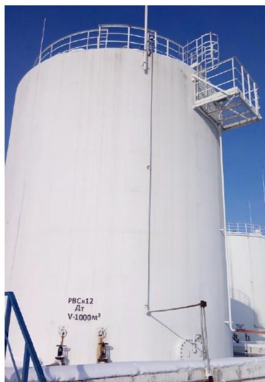
Рисунок 2 - Общий вид резервуара РВС-1000
