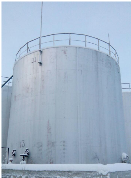
Рисунок 1 - Общий вид резервуара РВС-400
