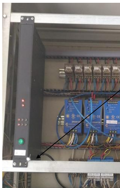
Рисунок 2 - Схема пломбировки контроллера NPA 2005-07B
