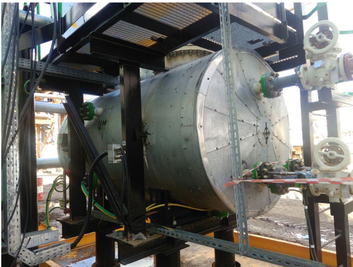
Рисунок 1 - Общий вид резервуара РГС-2,5
