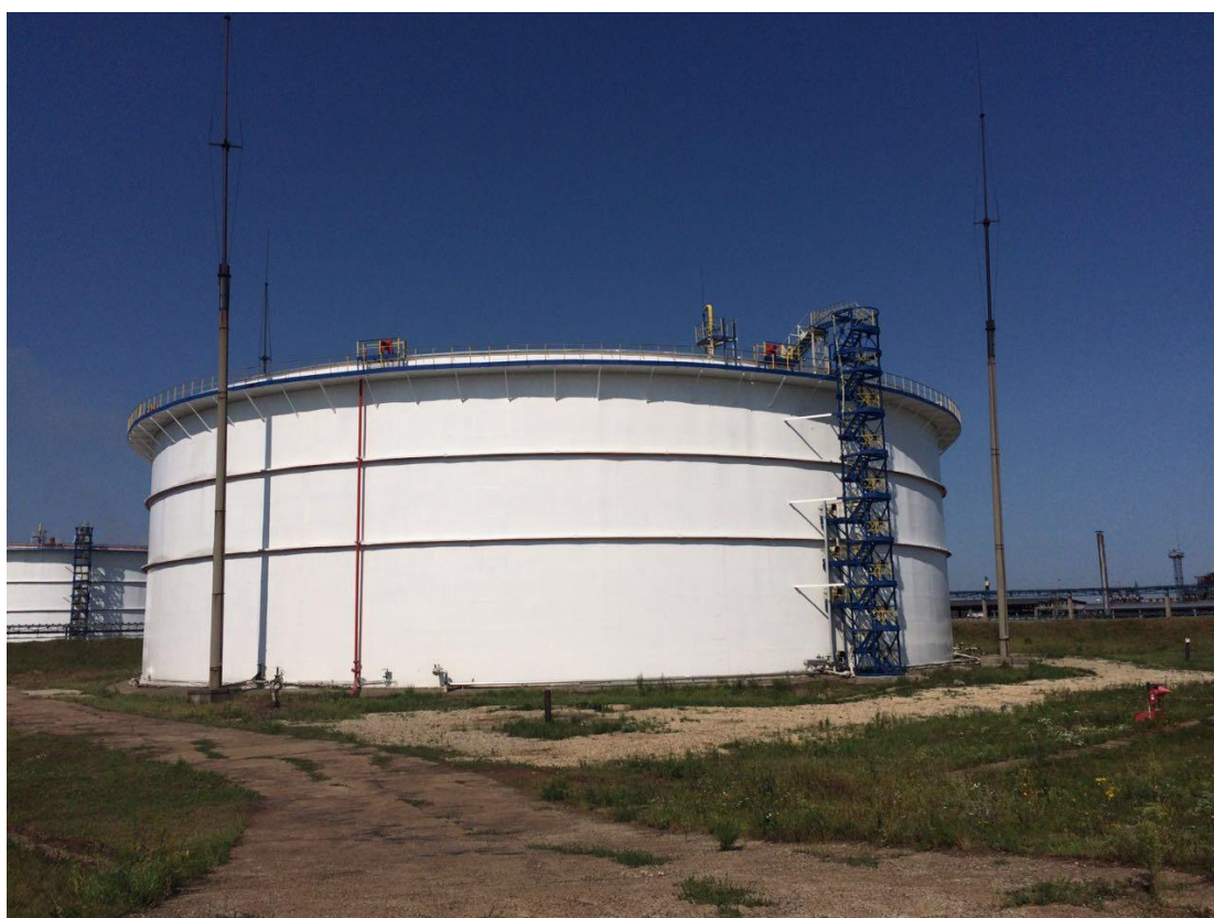
Рисунок 1 - Общий вид резервуара РВСПК-50000
