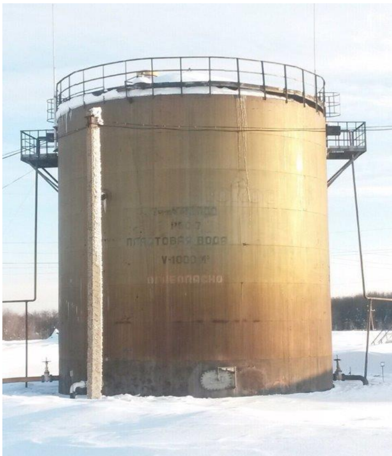
Рисунок 1 - Общий вид резервуара стального вертикального цилиндрического РВС-1000
