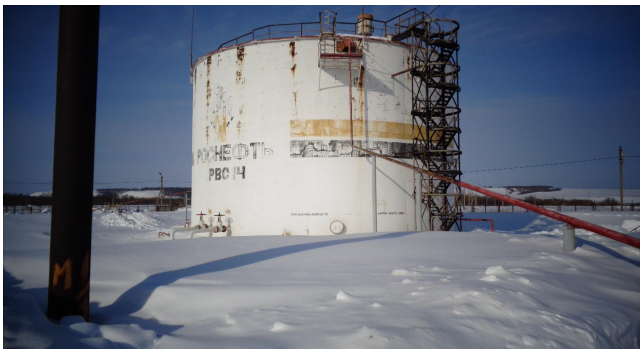
Рисунок 3 - Общий вид резервуара стального вертикального цилиндрического РВС-3000
