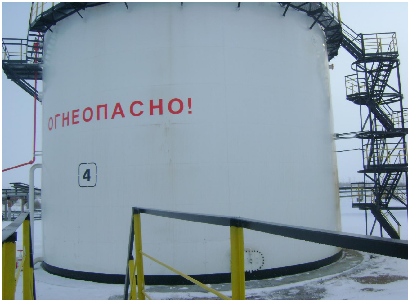
Рисунок 2 - Общий вид резервуара стального вертикального цилиндрического РВС-2000
