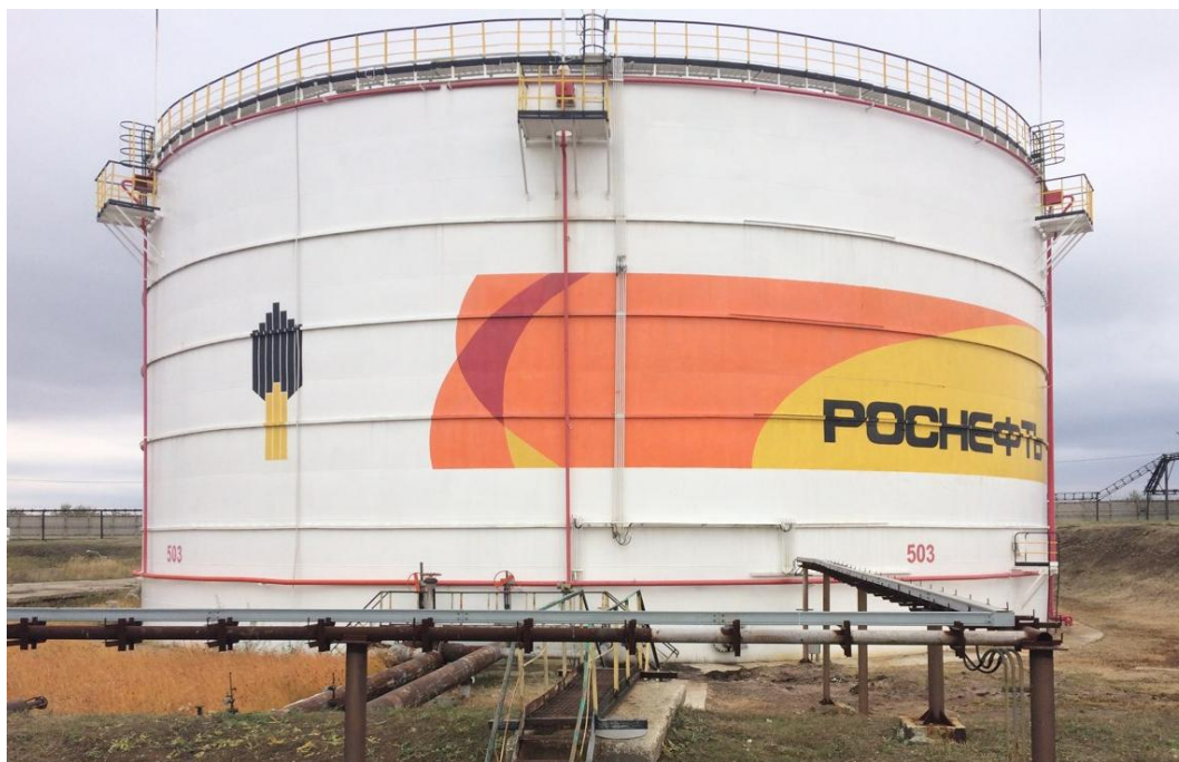
Рисунок 2 - Общий вид резервуара РВСП-20000
