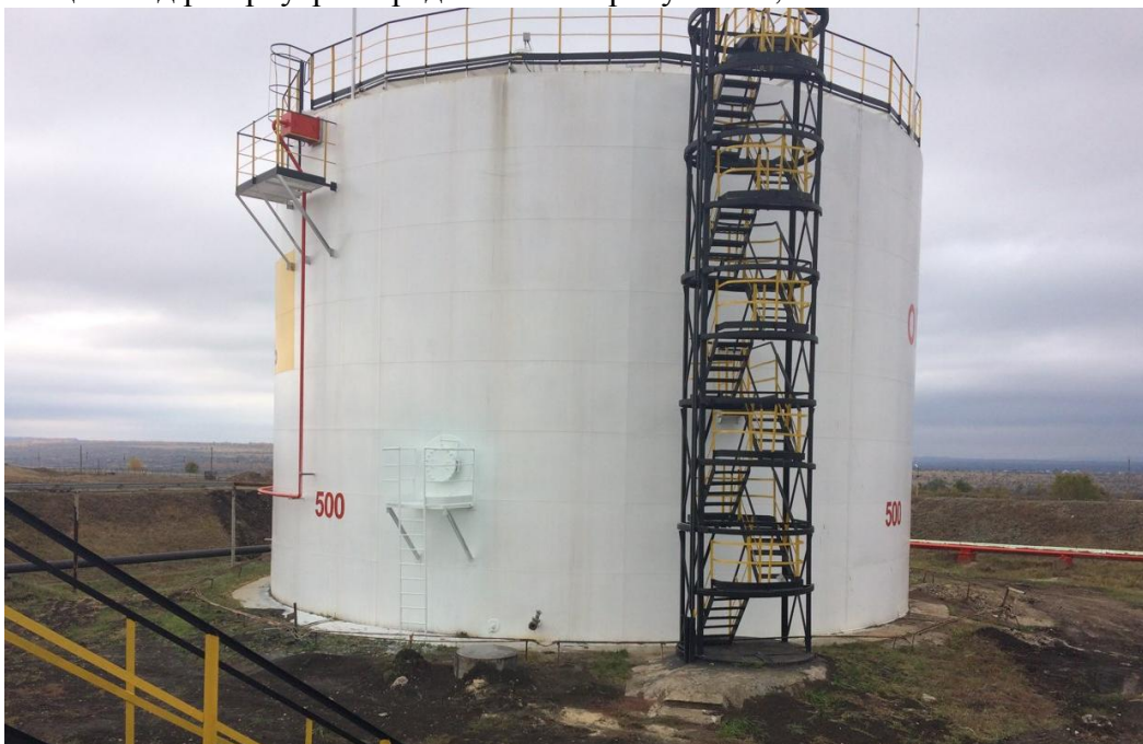
Рисунок 1 - Общий вид резервуара РВСП-3000
