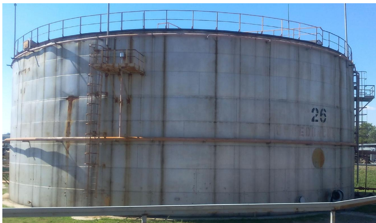
Рисунок 3 - Общий вид резервуара вертикального стального цилиндрического РВСП-8000
