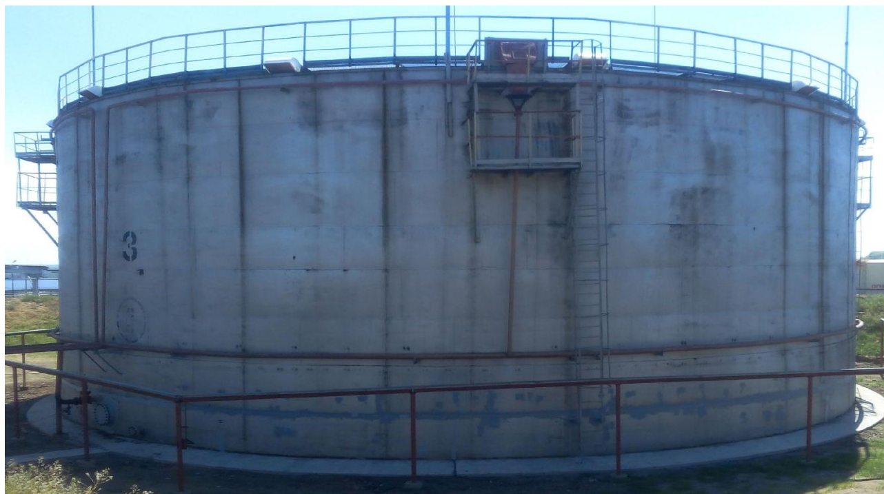
Рисунок 1 - Общий вид резервуара стального вертикального цилиндрического РВС-1000
