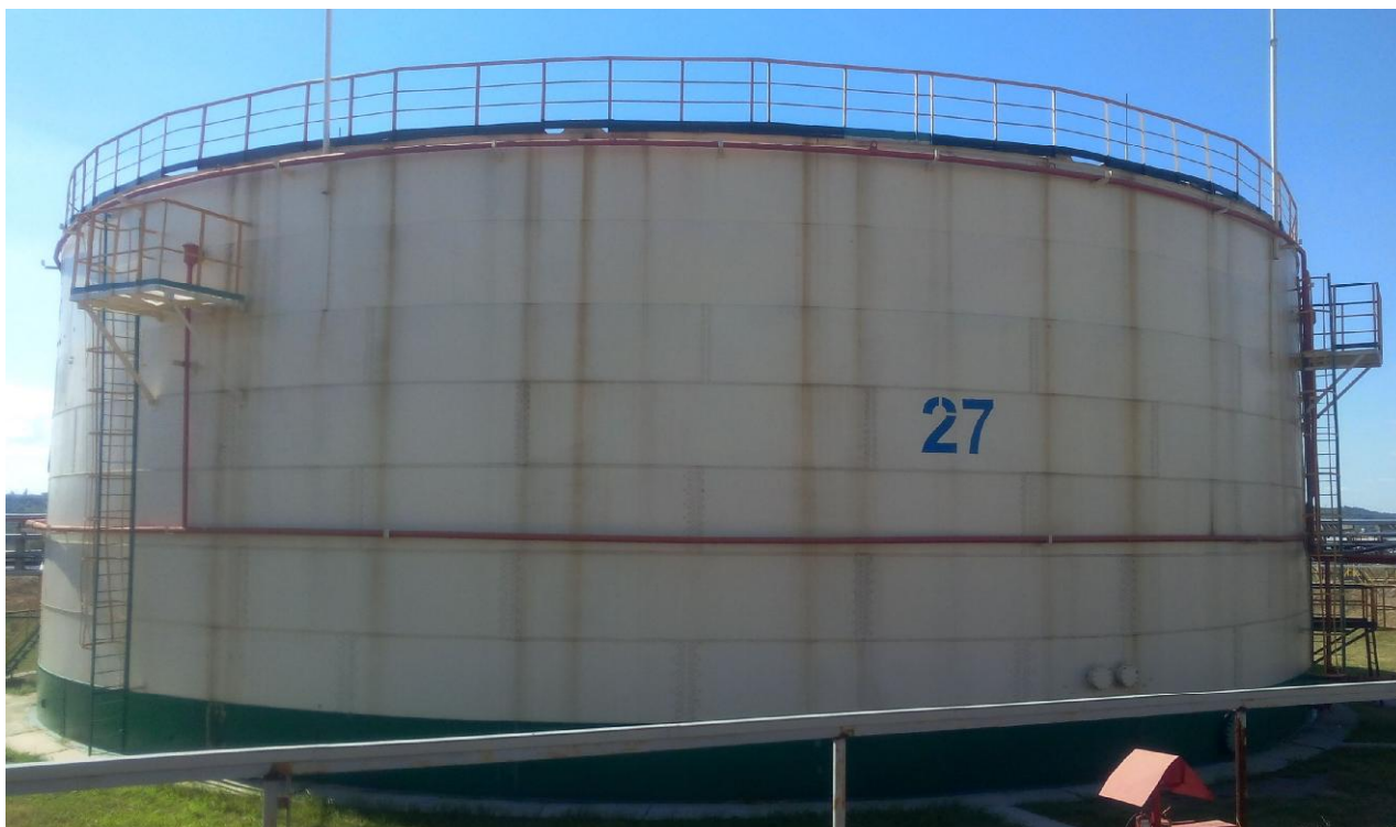
Рисунок 4 - Общий вид резервуара вертикального стального цилиндрического РВСП-10000
