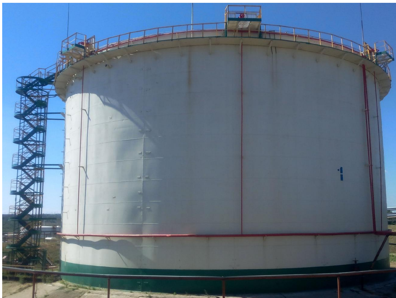
Рисунок 5 - Общий вид резервуара вертикального стального цилиндрического РВСПк-50000
