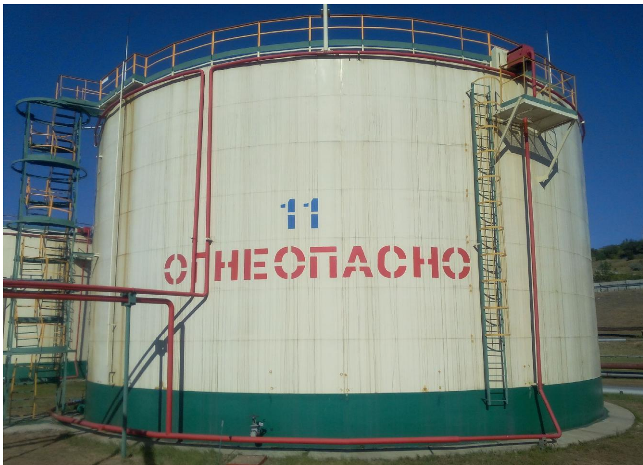
Рисунок 2 - Общий вид резервуара стального вертикального цилиндрического РВС-5000
