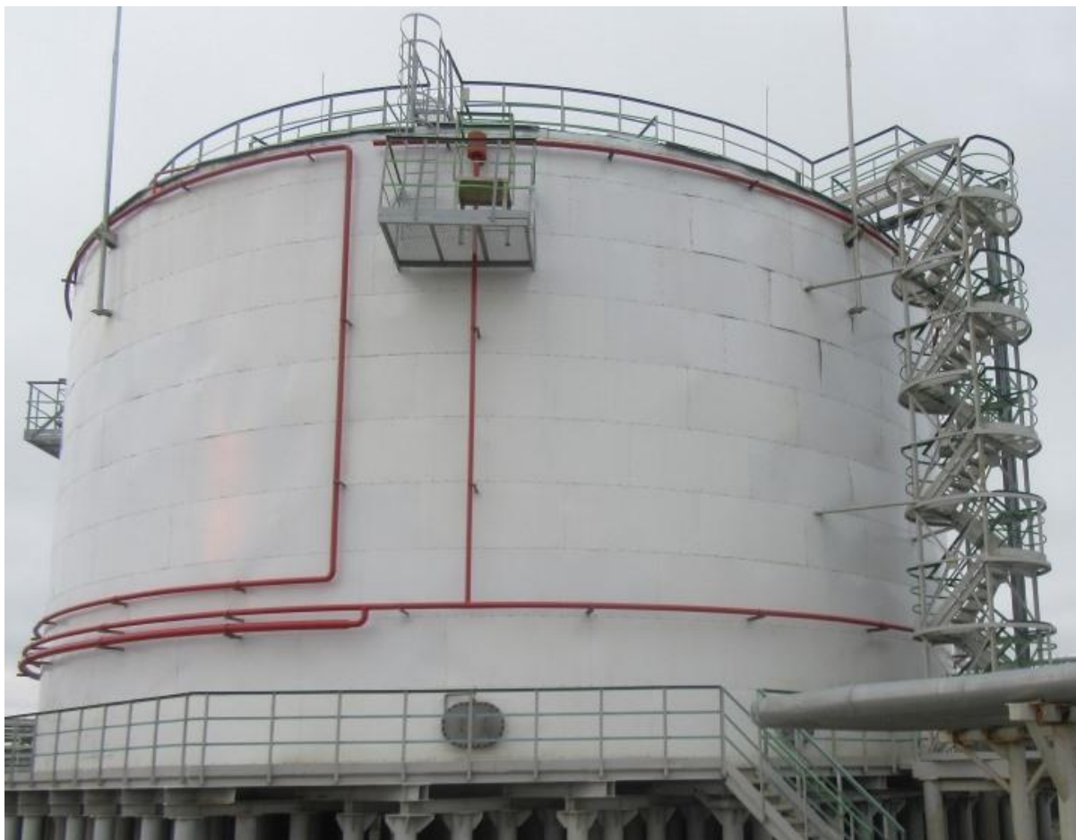
Рисунок 1 - Общий вид резервуара стального вертикального цилиндрического РВС-5000
