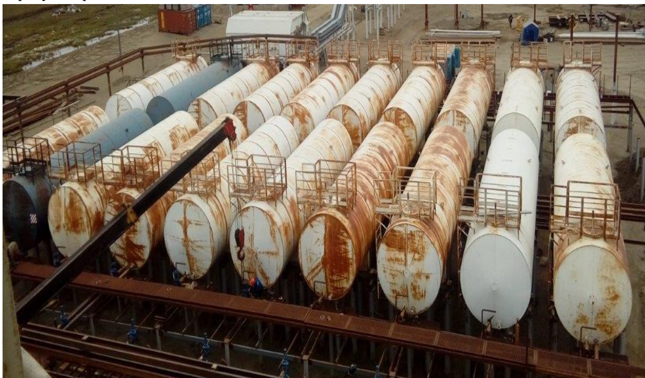
Рисунок 1 - Общий вид резервуара стального горизонтального цилиндрического РГС-100
