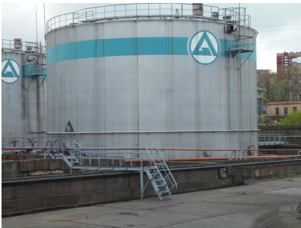
Рисунок 1 - Общий вид резервуара РВС-4000 № 61
