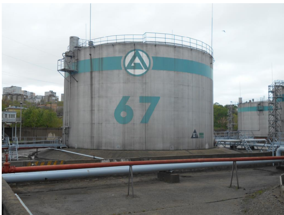
Рисунок 3 - Общий вид резервуара РВС-4000 № 67
