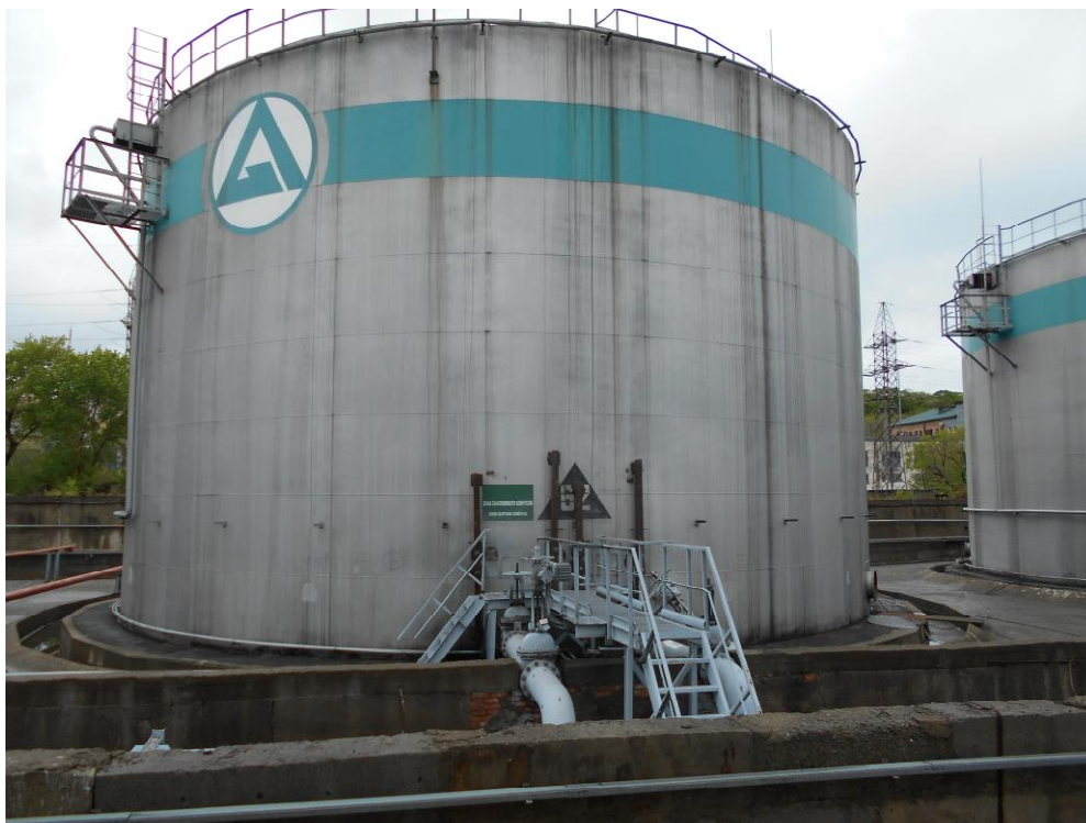
Рисунок 2 - Общий вид резервуара РВС-4000 № 62
