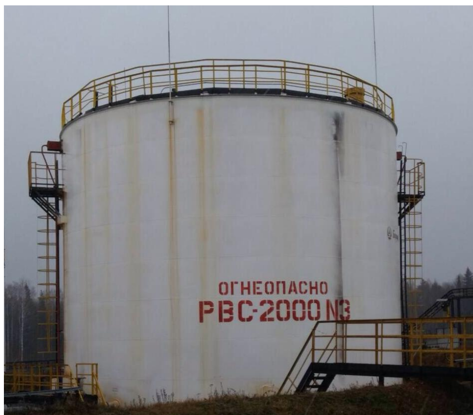
Рисунок 1 - Общий вид резервуара РВС-2000
