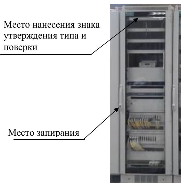
Рисунок 22 - Места расположения наклеек и запираания стойки приборной АИИС
