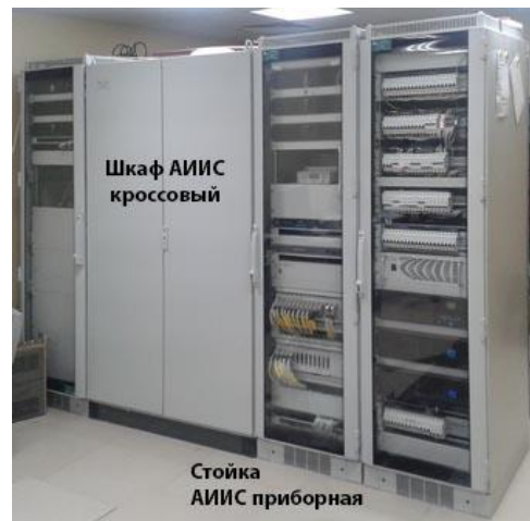
Рисунок 2 - Стойки и шкафы АИИС. Расположение
