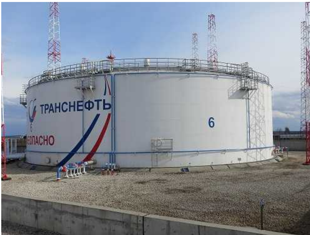
Рисунок 3 - Общий вид резервуара вертикального стального цилиндрического РВСП-20000
