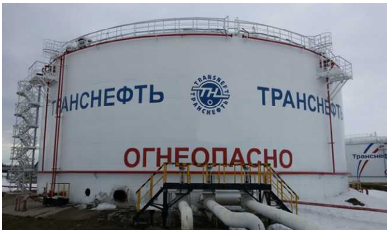
Рисунок 1 - Общий вид резервуара вертикального стального цилиндрического РВС-10000
