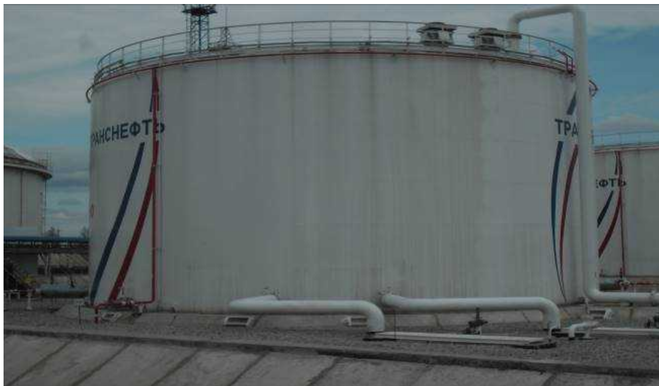
Рисунок 2 - Общий вид резервуара вертикального стального цилиндрического РВСП-5000
