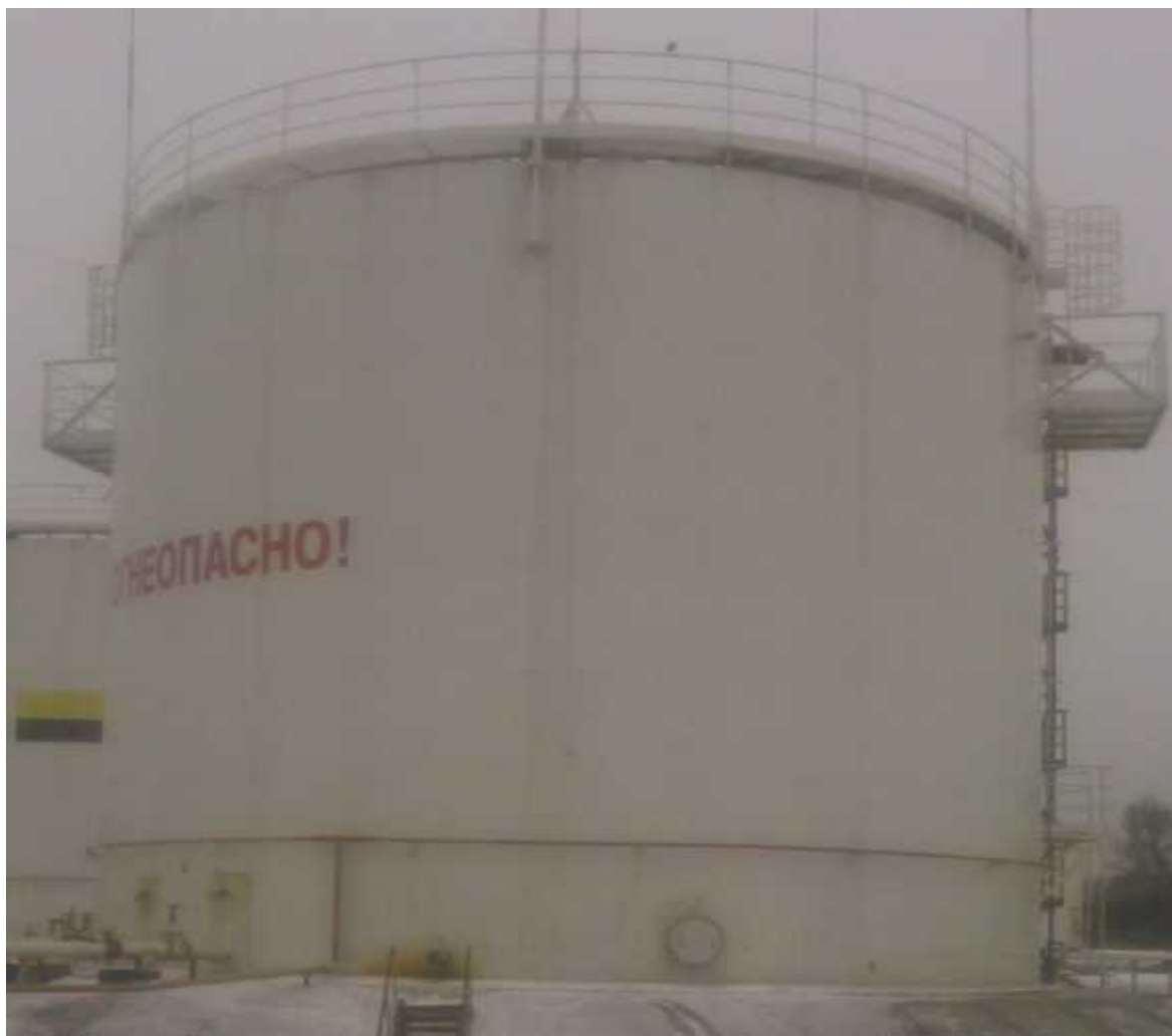
Рисунок 1 - Общий вид резервуара стального вертикального цилиндрического РВСП-2000
