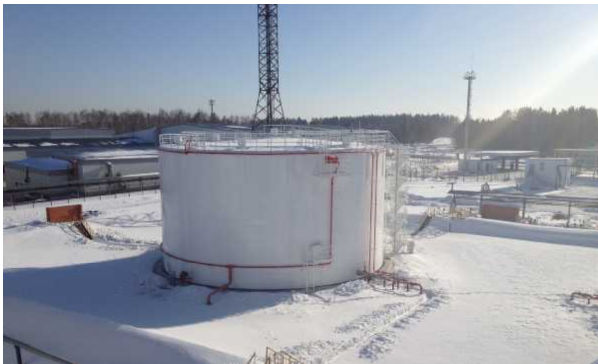
Рисунок 1 - Общий вид резервуара вертикального стального цилиндрического РВС-5000
