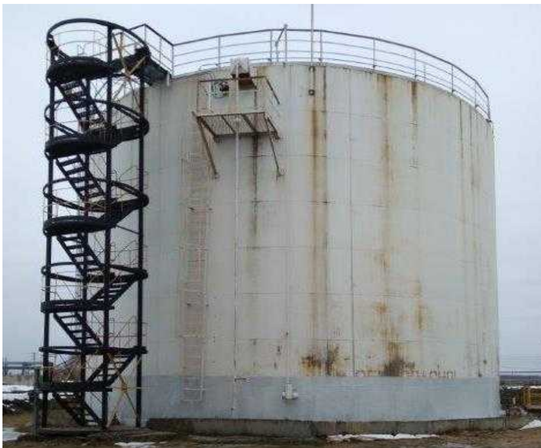
Рисунок 2 - Общий вид резервуара стального вертикального цилиндрического РВС-2000
