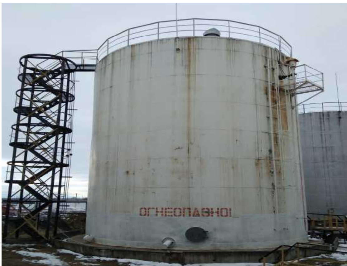
Рисунок 1 - Общий вид резервуара стального вертикального цилиндрического РВСП-1000
