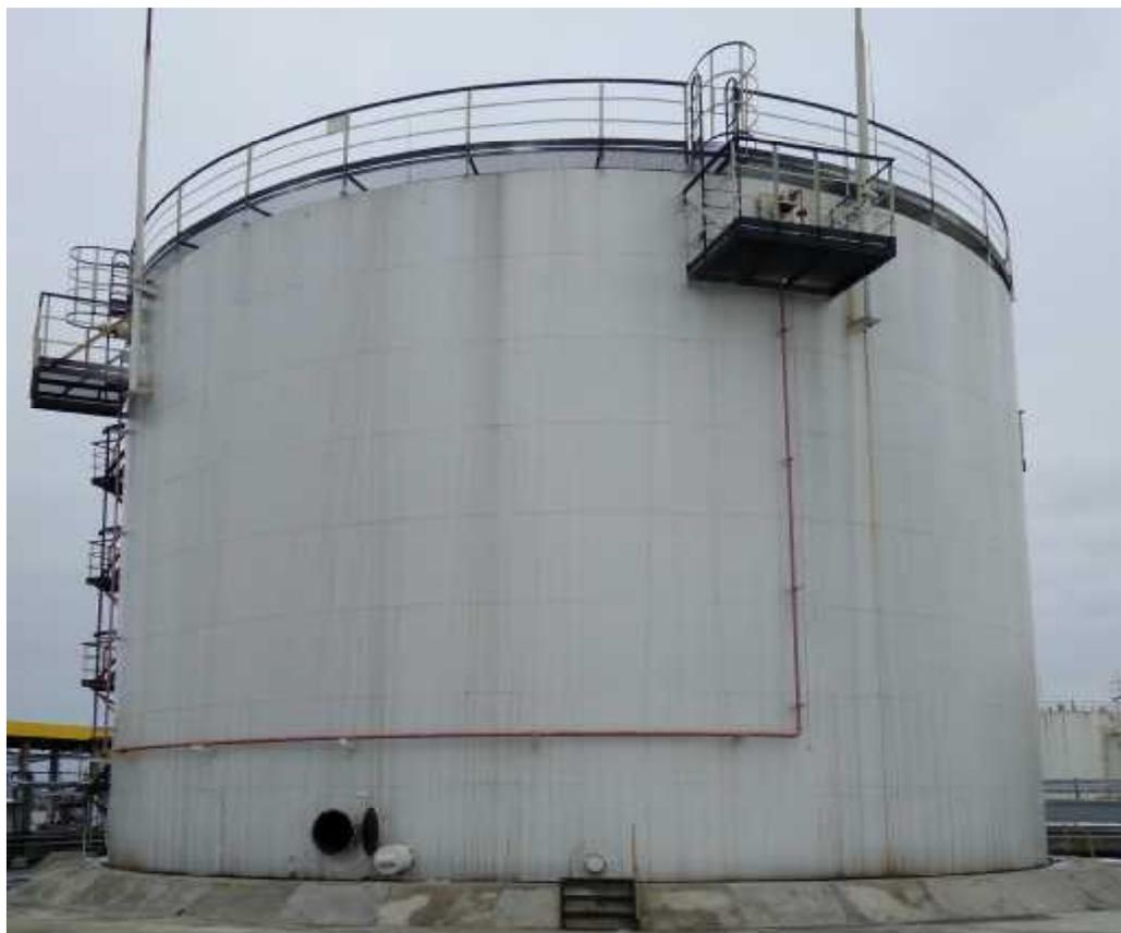
Рисунок 3 - Общий вид резервуара стального вертикального цилиндрического РВС-3000
