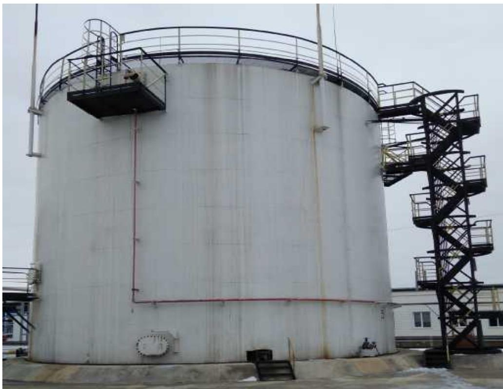
Рисунок 2 - Общий вид резервуара стального вертикального цилиндрического РВСП-2000
