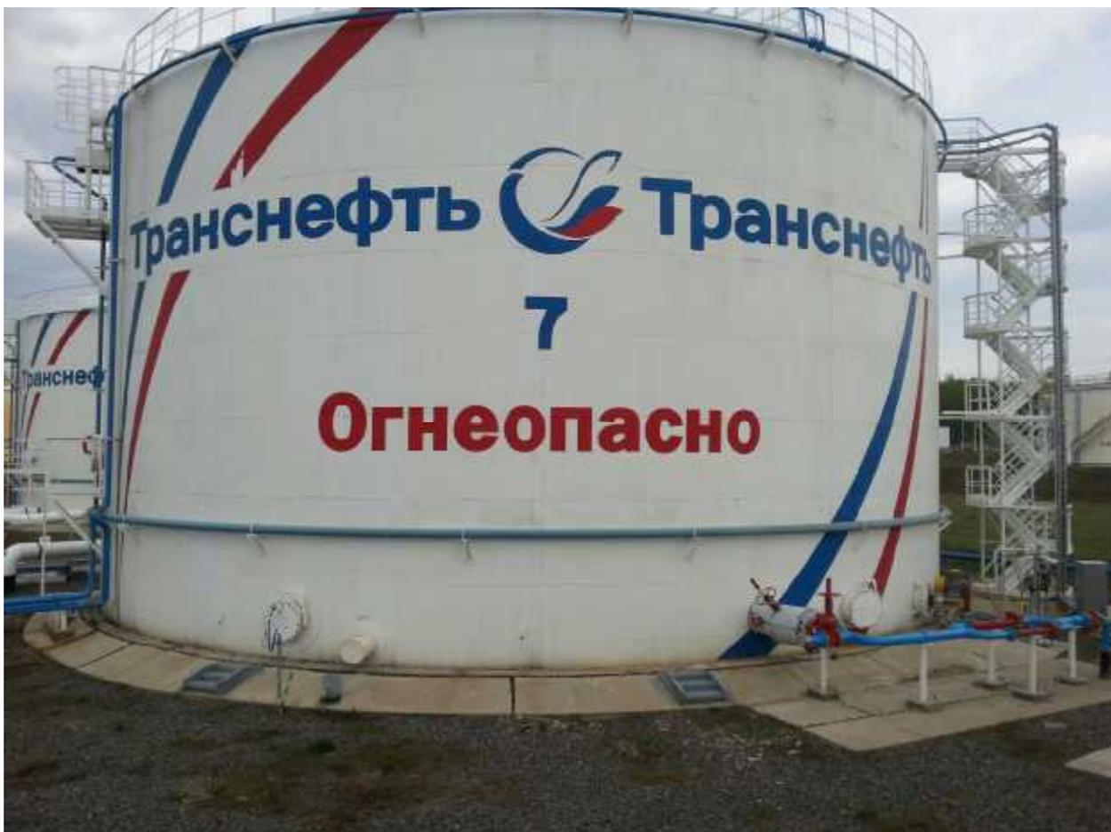
Рисунок 1 - Общий вид резервуара вертикального стального цилиндрического РВСП-5000
