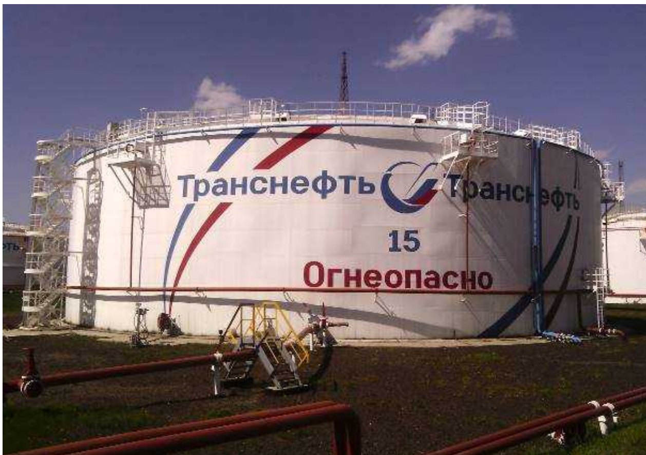
Рисунок 2 - Общий вид резервуара вертикального стального цилиндрического РВСП-20000
