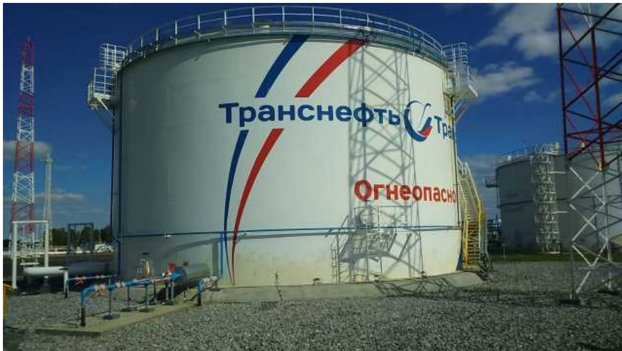
Рисунок 1 - Общий вид резервуара вертикального стального цилиндрического РВС-5000
