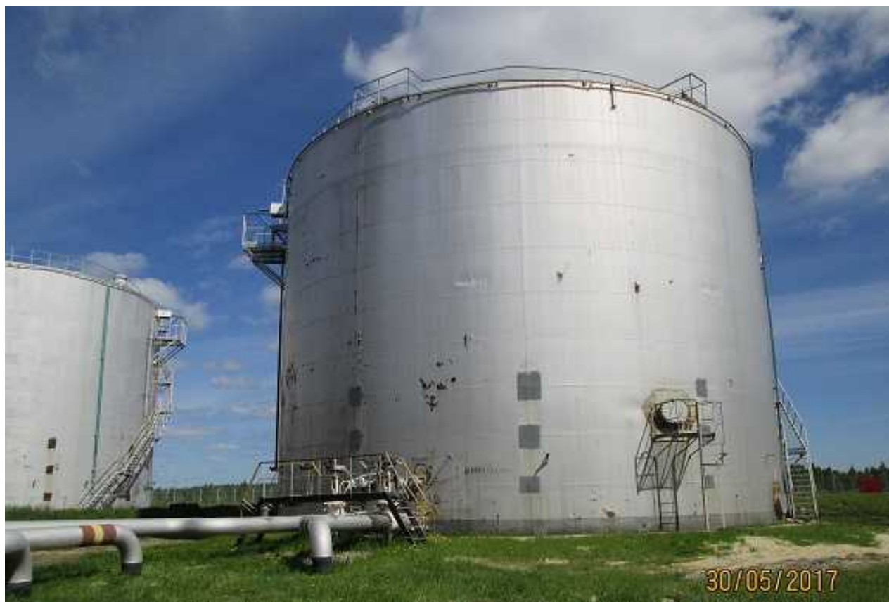
Рисунок 3 - Общий вид резервуара вертикального стального цилиндрического РВСП-5000
