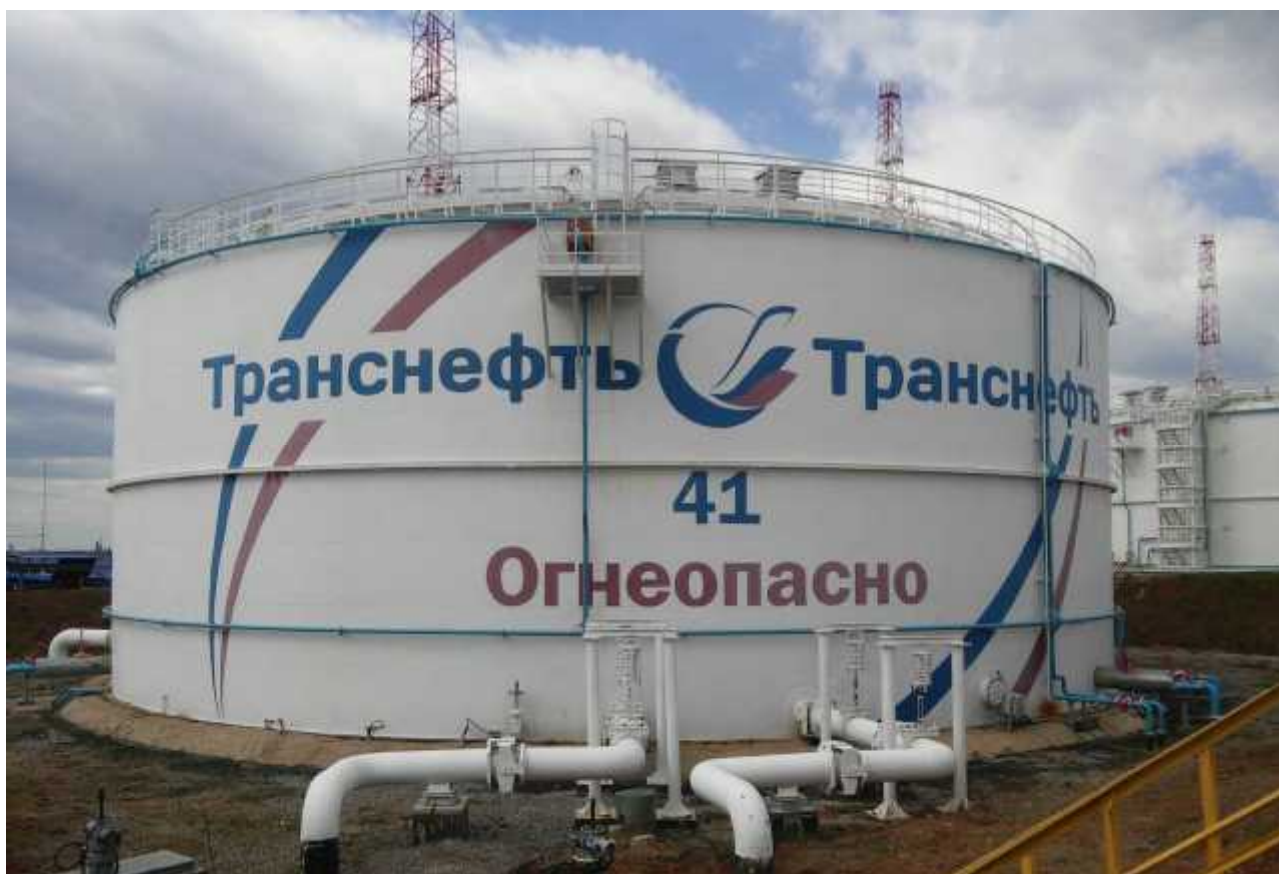
Рисунок 2 - Общий вид резервуара вертикального стального цилиндрического РВС-10000
