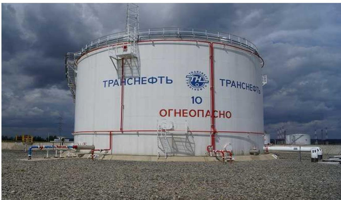
Рисунок 1 - Общий вид резервуара вертикального стального цилиндрического РВСП-5000
