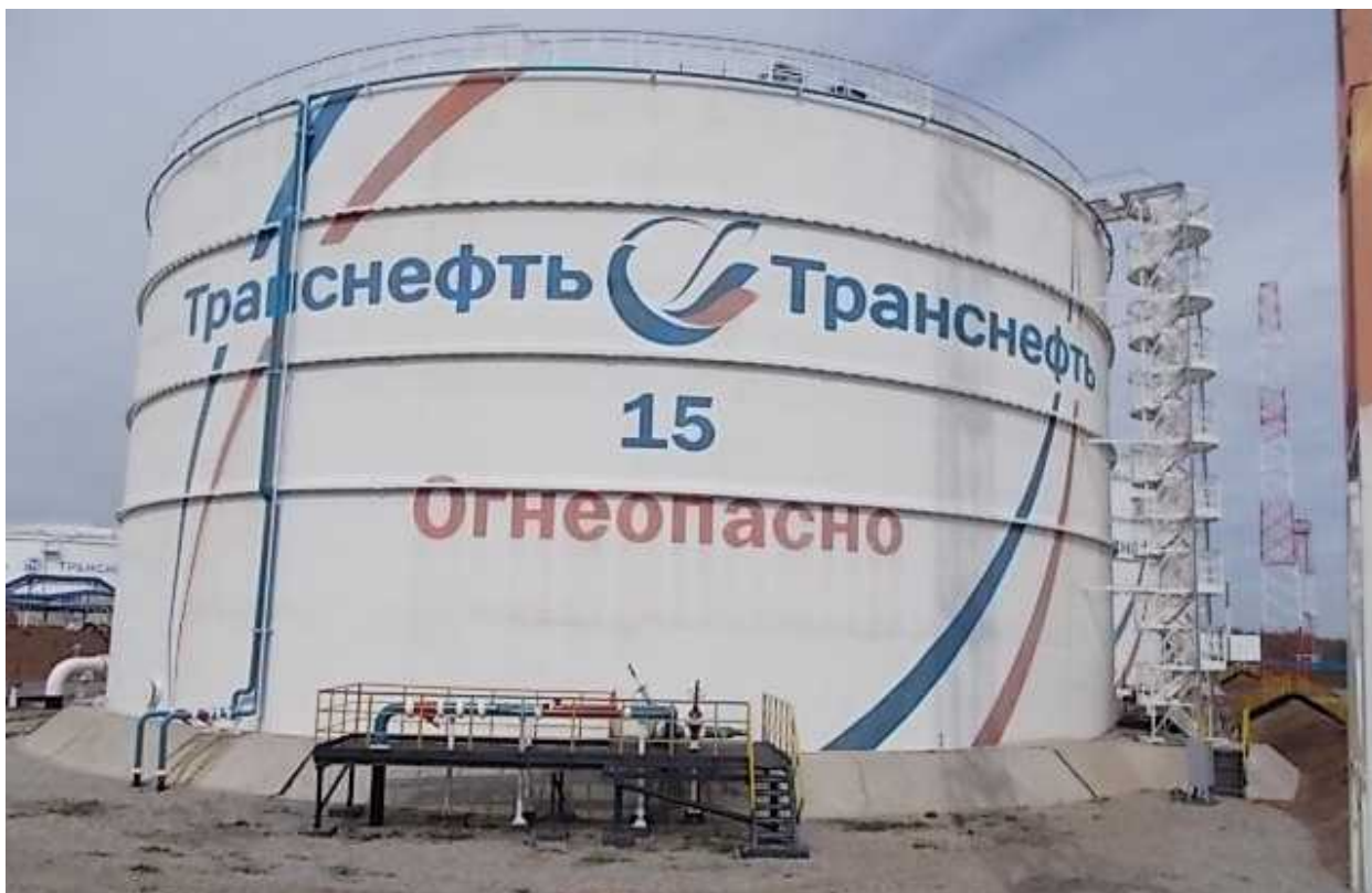
Рисунок 1 - Общий вид резервуара вертикального стального цилиндрического РВС-20000
