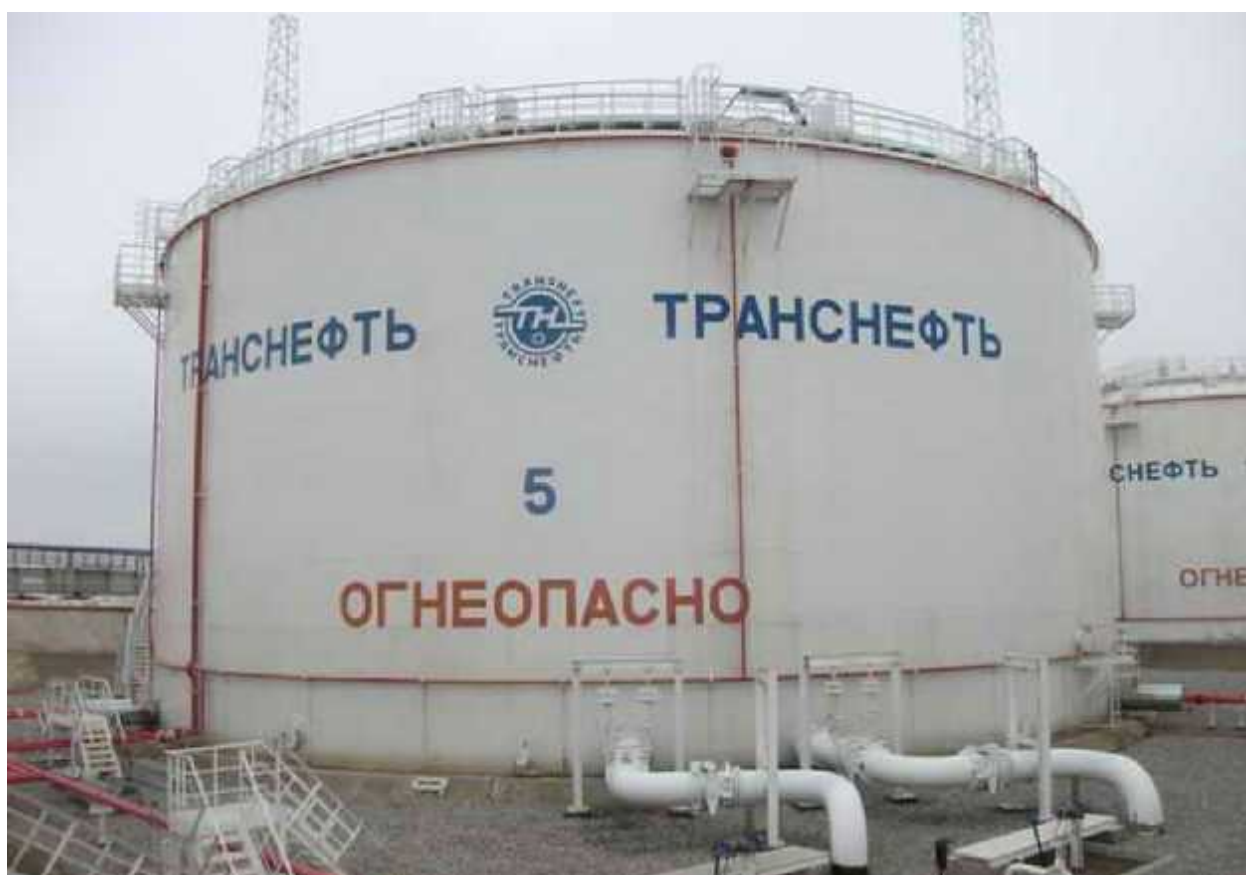
Рисунок 2 - Общий вид резервуара вертикального стального цилиндрического РВСП-20000
