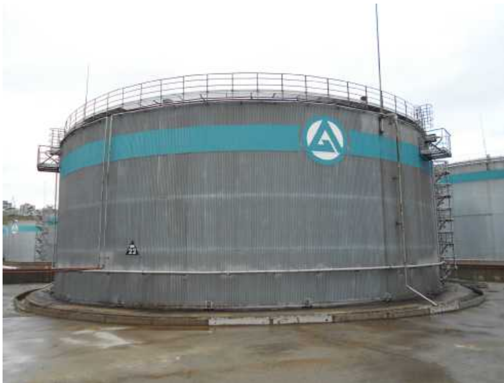
Рисунок 1 - Общий вид резервуара РВС-10000 № 22
