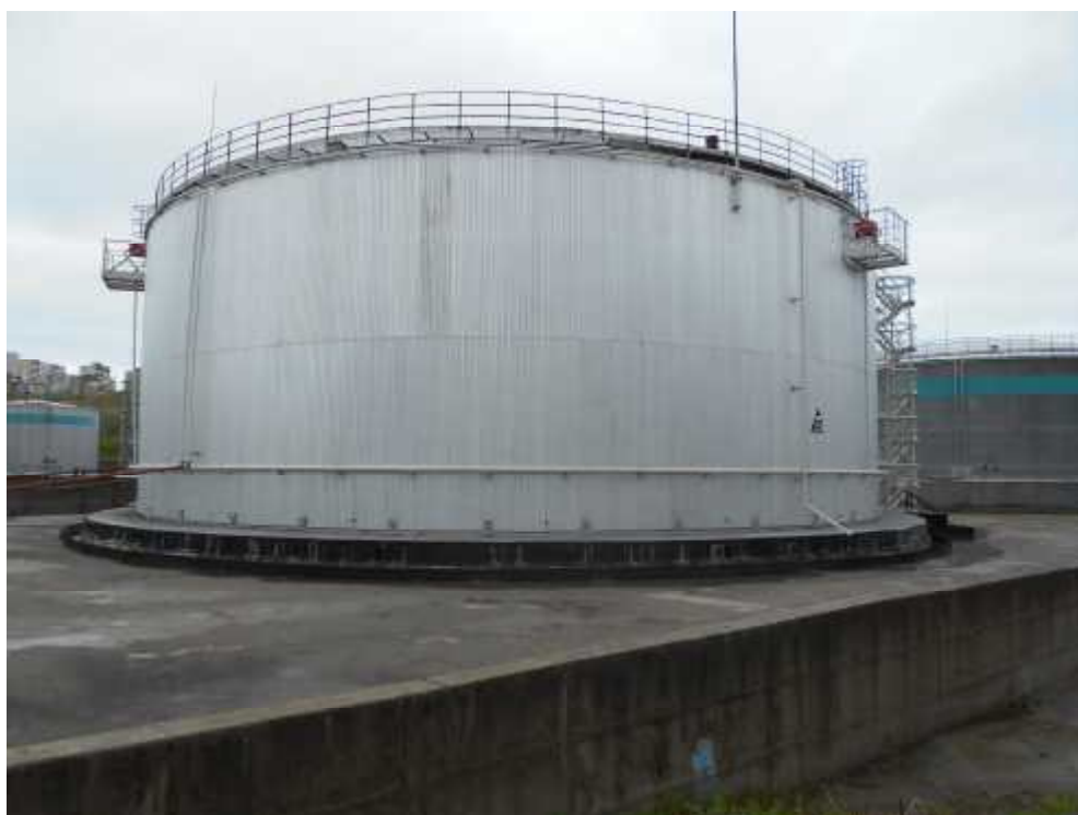
Рисунок 3 - Общий вид резервуара РВС-10000 № 24
