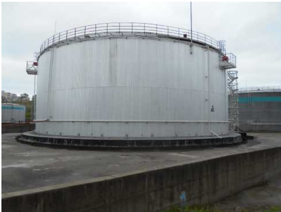
Рисунок 2 - Общий вид резервуара РВС-10000 № 23
